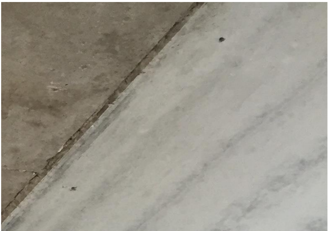
Kuva 1. Ontelolaattojen vesireiät paikallavalukaistojen vieressä.
