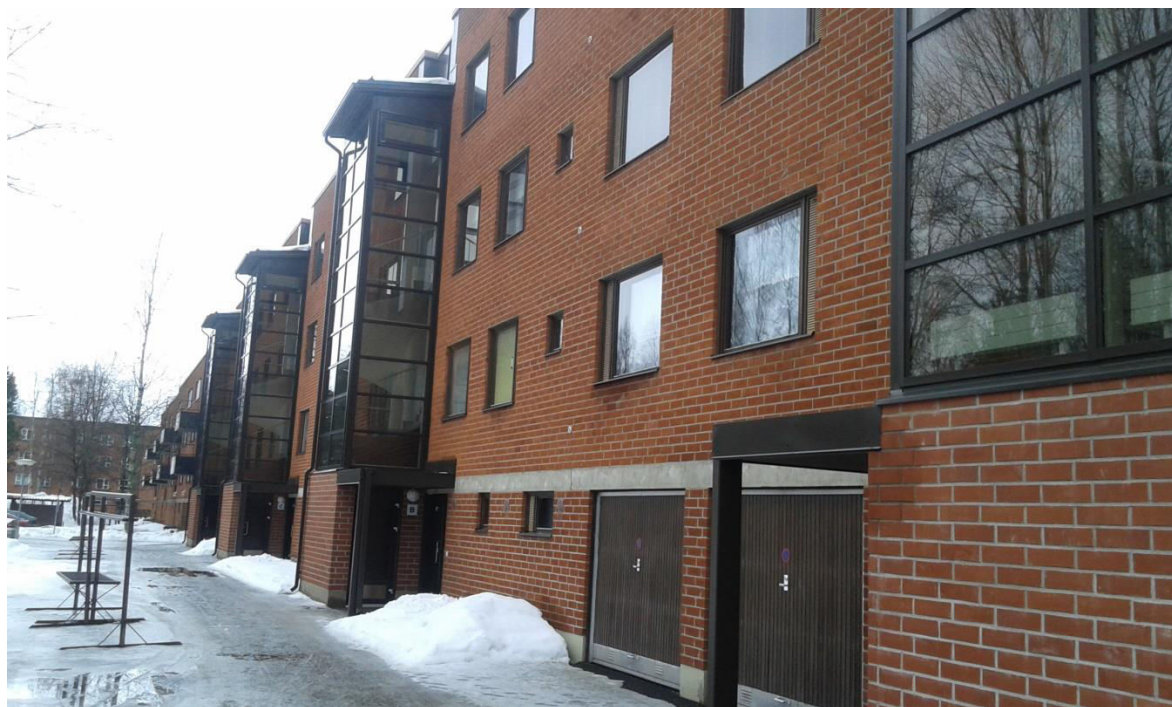
Kuva 1. Uudet porrashuoneet osana julkisivua. (Hentelä 2015)
