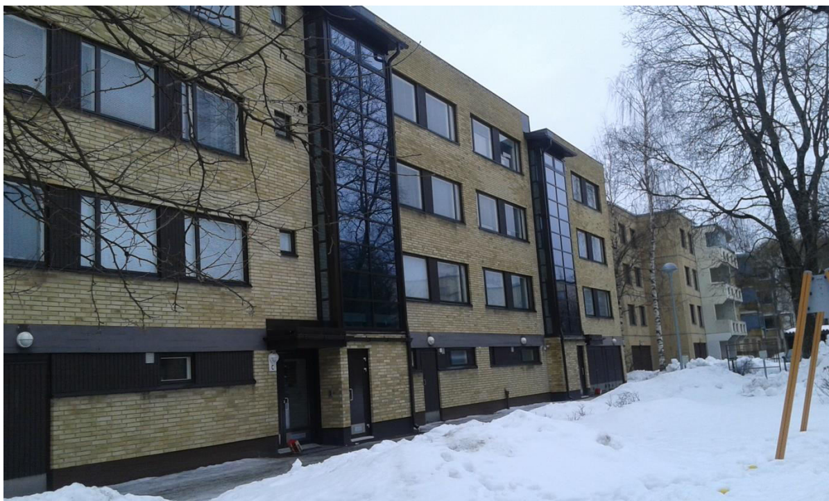
Kuva 2. Porrashuoneet rakennettu olemassa olevaan syvennykseen. (Hentelä 2015)
