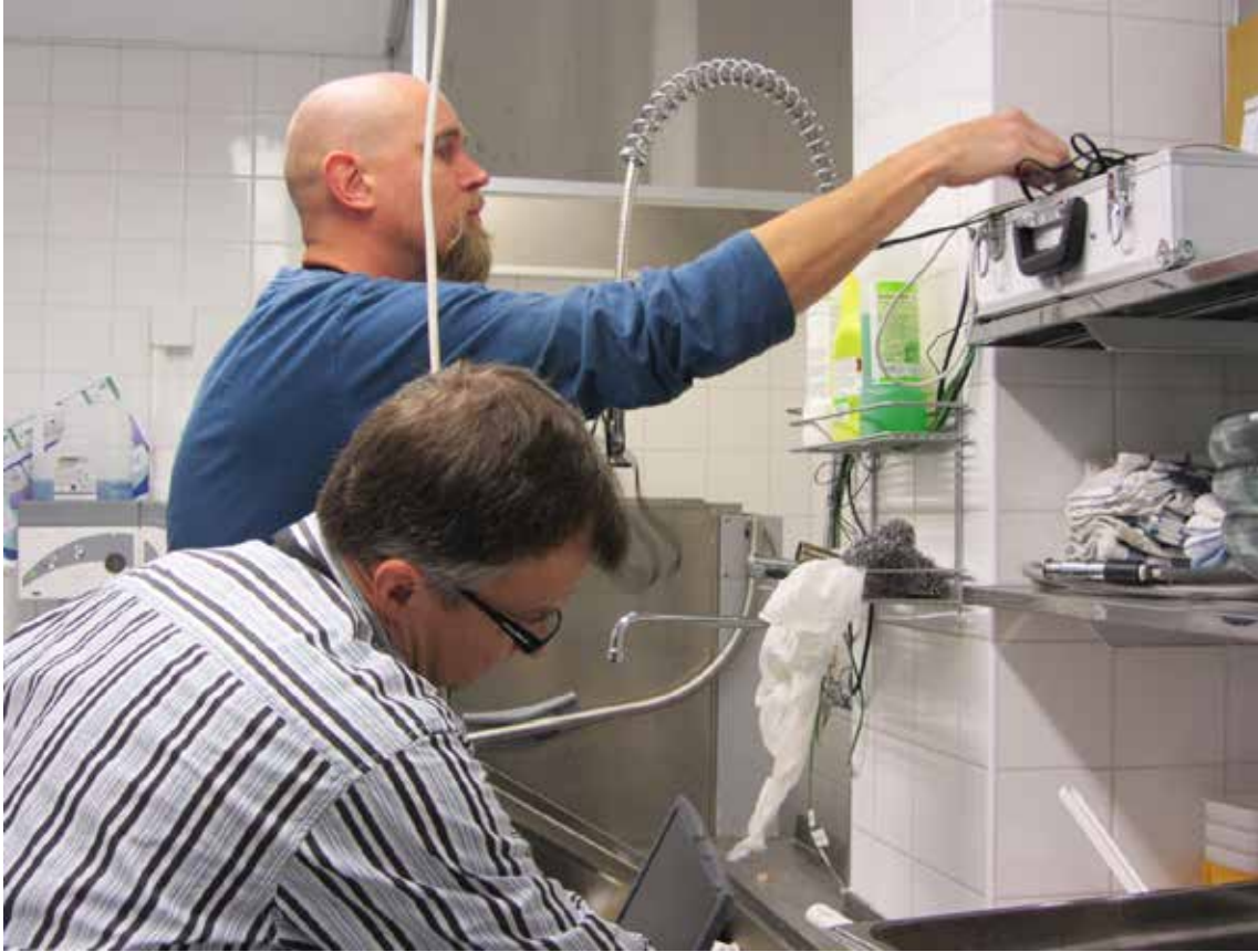
Kuva 1–1. Teollisen ja tieteellisen tutkimuksen konkreettinen kohtaaminen. Oras Oy:n tuotelaadun hallinnan päällikkö Jari Jäpölä (edessä) ja laboratorioteknikko Manne Santonen asentamassa jatkuvatoimista vesijohtoverkoston paine- ja lämpötilamittaria mittausaineiston tuottamiseksi tutkijoiden käyttöön Teknologiatalo Sytyttimessä.
