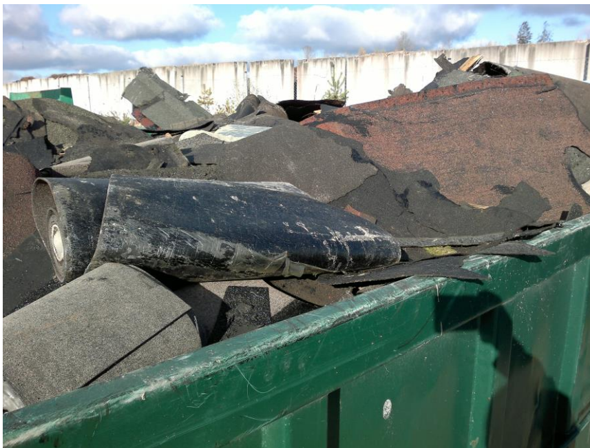
Kuva 17. Kattohuopajätelava PHJ:n Lahden Pilleri-jäteasemalla
