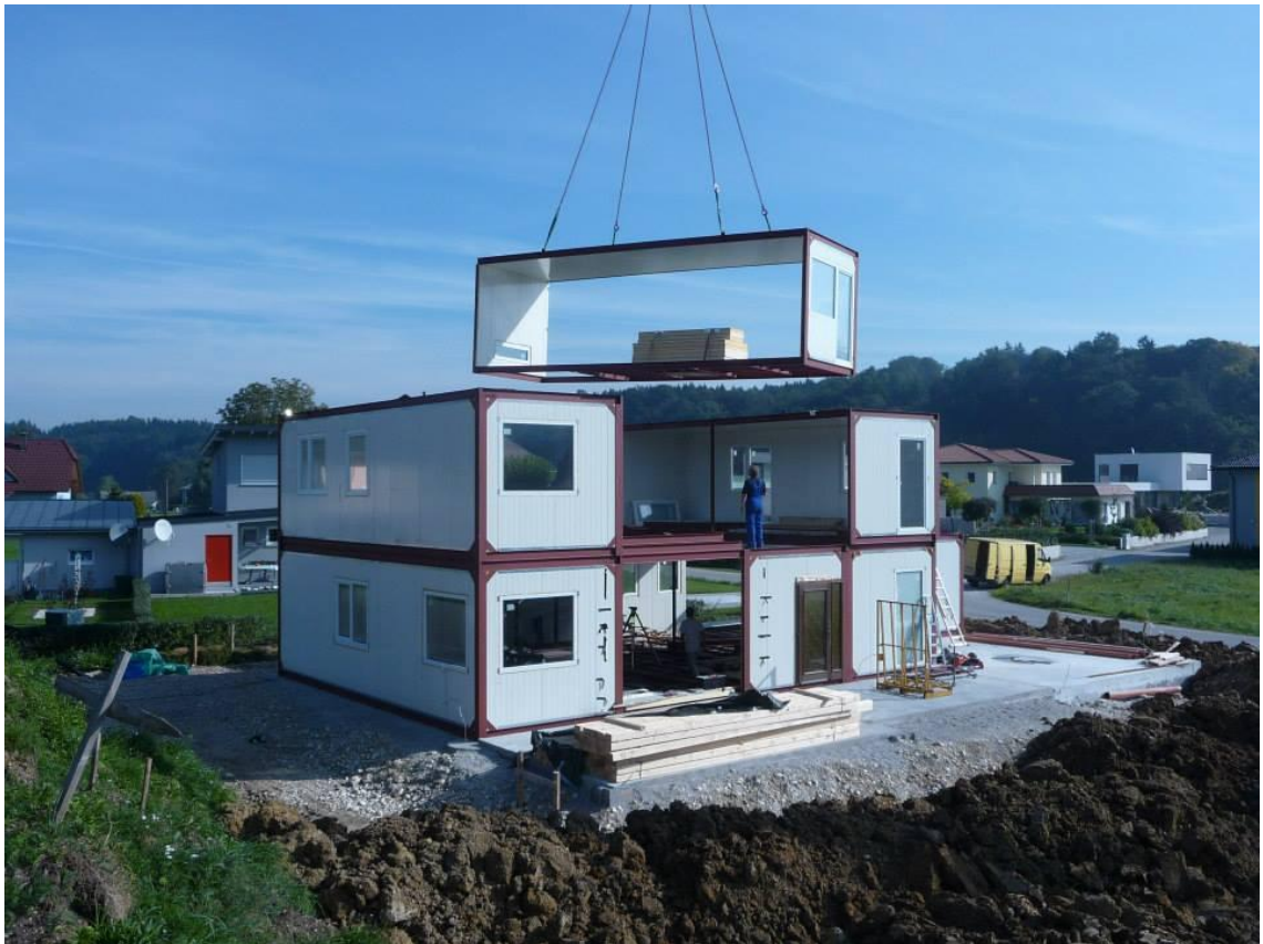
Kuva 13. Konttien pystytys käynnissä Martin Hollinetzin konttitalotyömaalla Pohjois-Itävallassa [38].
