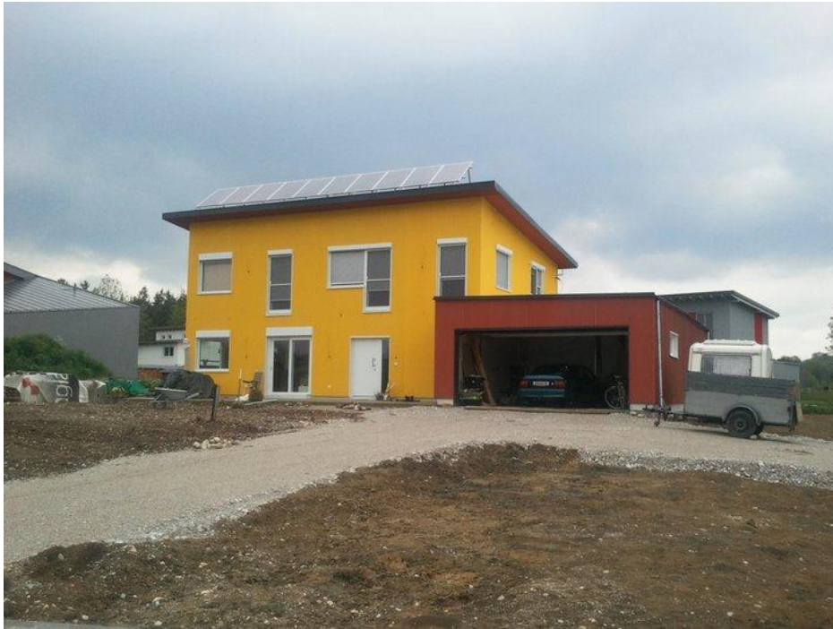
Kuva 14. Martin Hollinetzin Pohjois-Itävaltaan rakennuttama konttitalo valmiina pihatöitä lukuun ottamatta [38].
