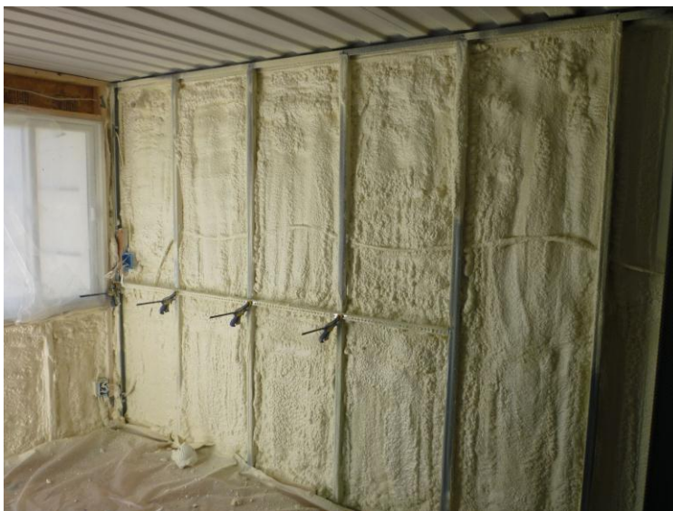
Kuva 19. Steven Schneiderin konttimetsästysmajan vaipan sisäpuolelle eristevaahdolla toteutettu lämmöneristyskerros [57].
