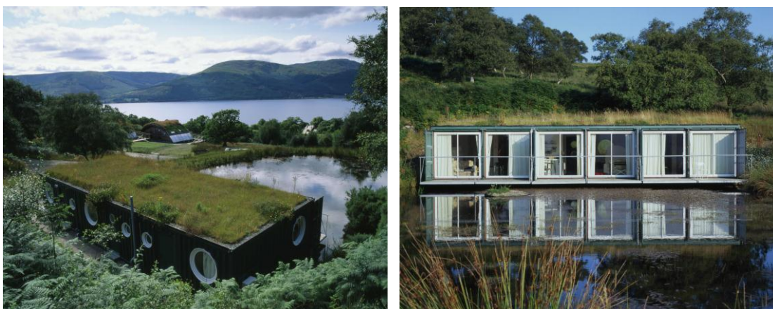
Kuva 21. Skotlannin länsirannikolla sijaitsevan Cove Park -taiteilijakeskuksen yläpohjaa on lämmöneristetty myös viherkatolla [62].
