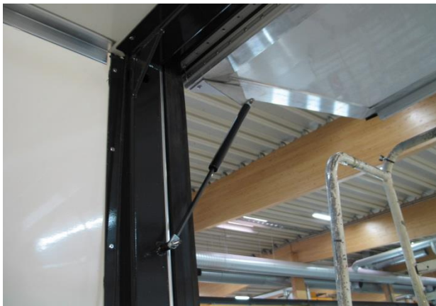
KUVA 12. Luukun kaasusylinterin asennus (Fokor 2015)
