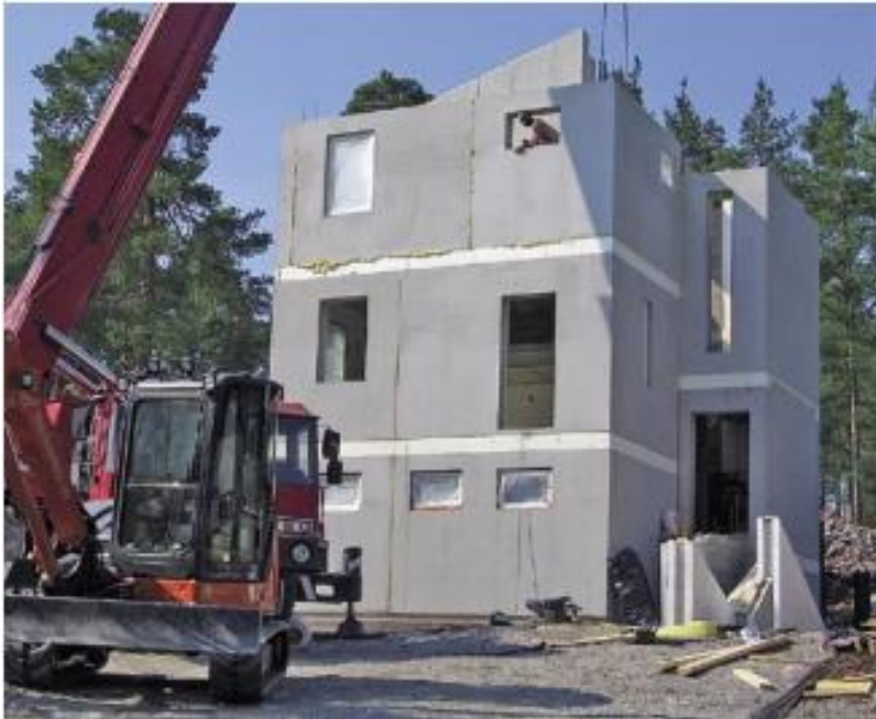
Kuvio 5. Eps-Betonielementtien asentaminen autonosturilla.
