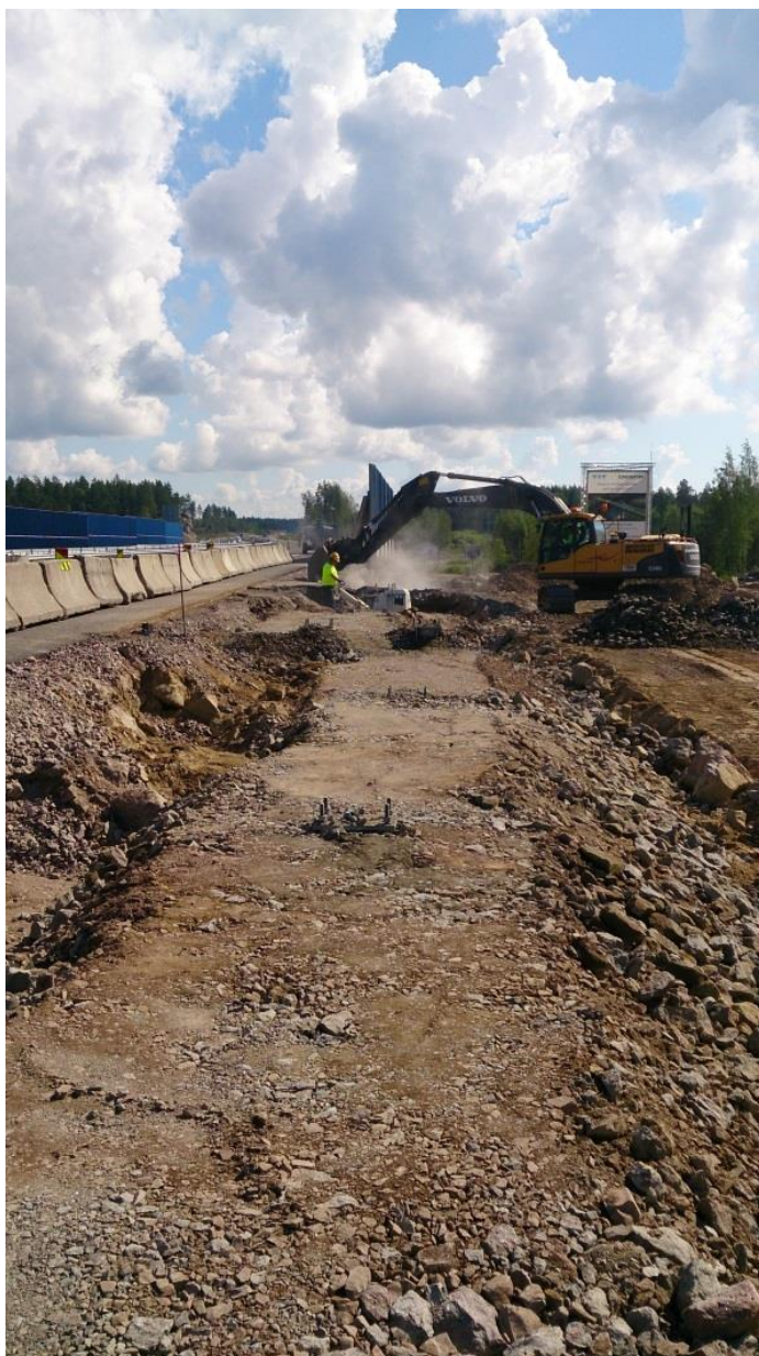
KUVA 9: Pilarijatkojen täyttötyötä Loviisan Hagalundissa kesällä 2014 (Akseli Musalo 2014)
