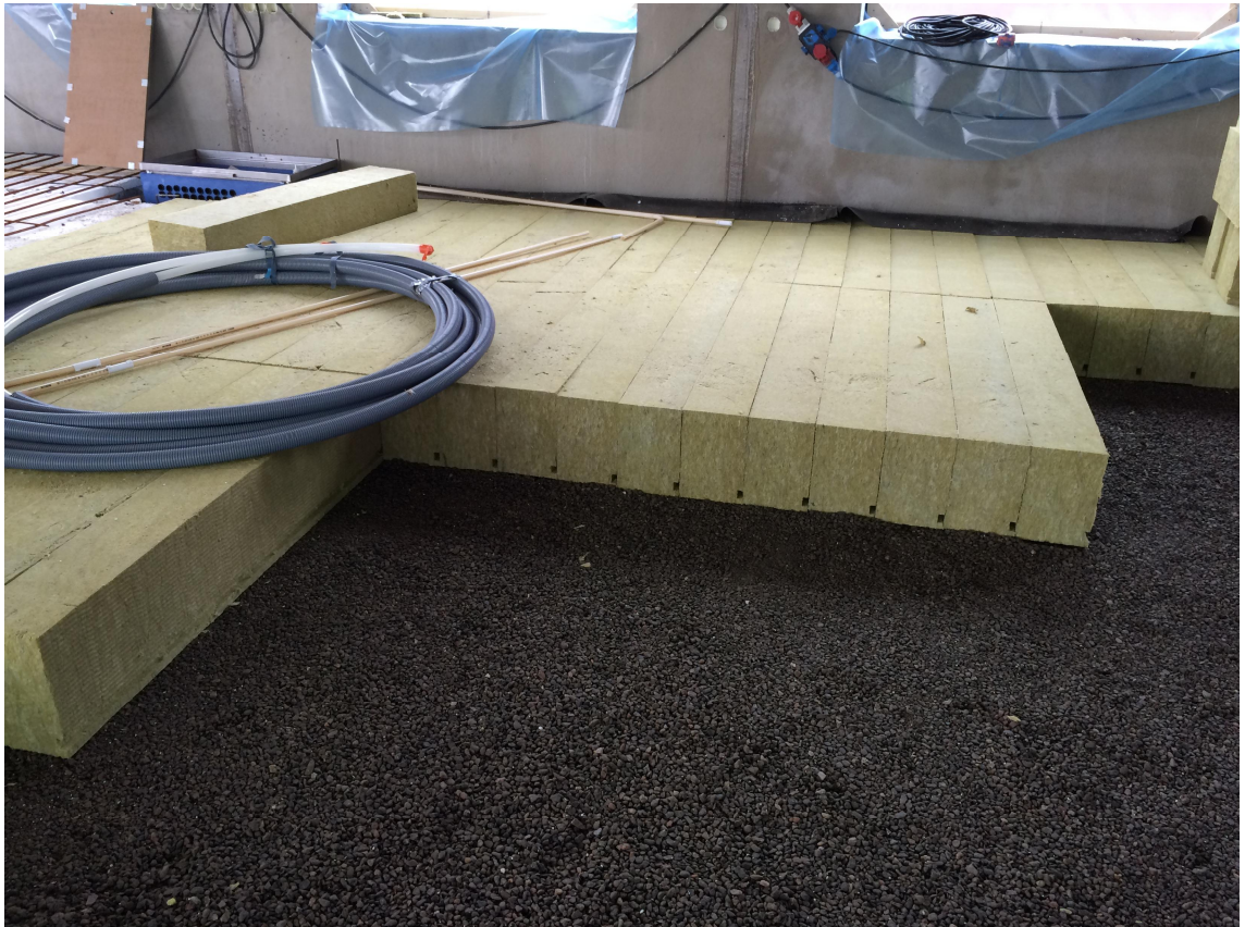
Kuva 27. Tutkittavan rakenteen Paroc COL 40g eristettä ladottuna Pieksämäen koekohteella. Kohteelle tilatut lamellit ovat mitoiltaan 200 x 1500 x 300 mm (leveys, pituus, paksuus).
