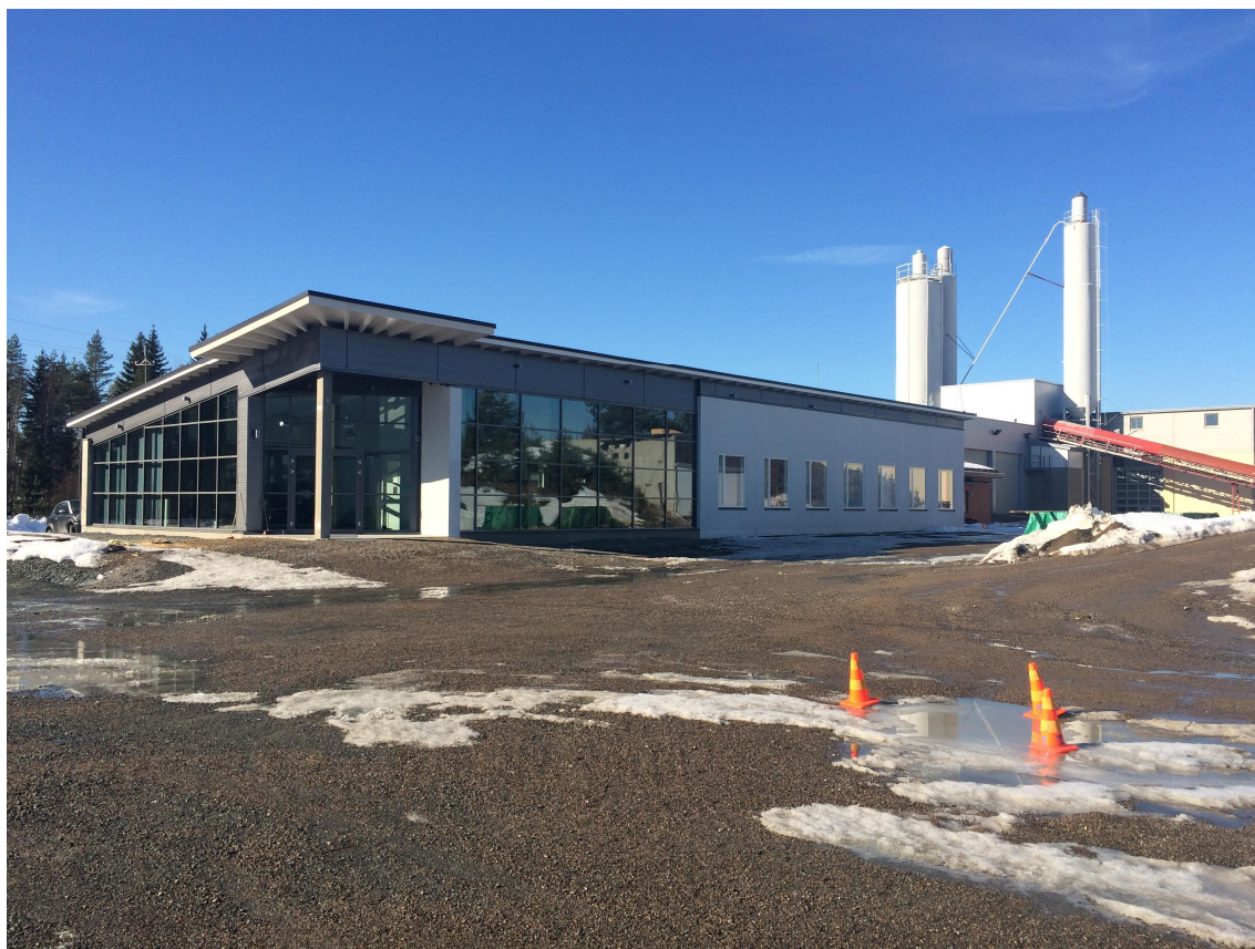
Kuva 31. Tutkimuksen koekohde. Toimiston laajennusosan takana näkyy Lipa-Betonin betonielementtitehdas.
