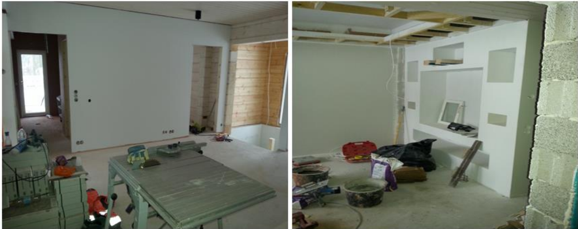
KUVA 6. Väliseinien ja alakattojen pintatyöt käynnissä
