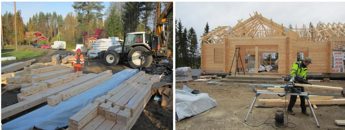
KUVA 2. Hirsipakettien aukaisua ja tarkastelua työmaalla
