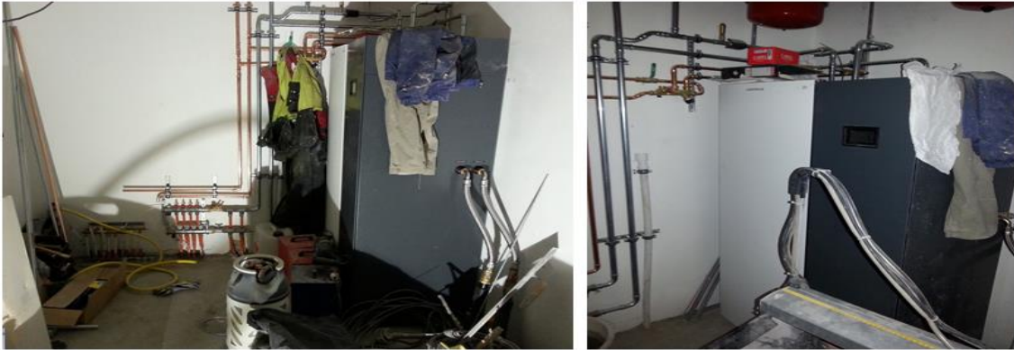
KUVA 4. LVI-laitteiden asennusta teknisessä tilassa
