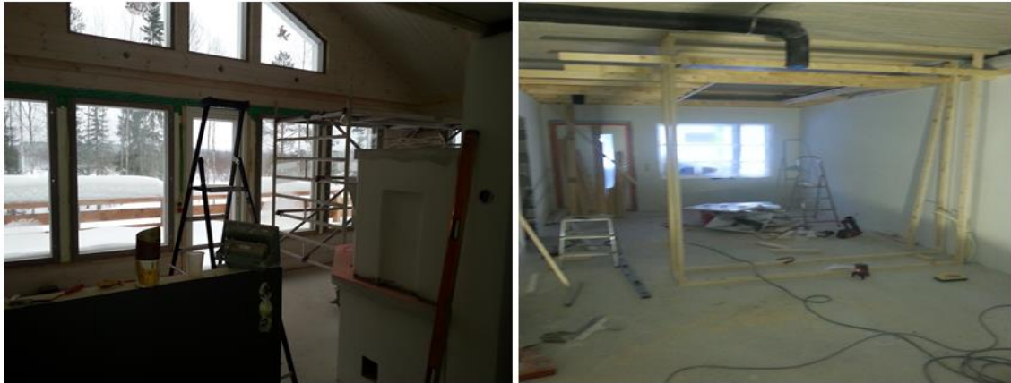
KUVA 5. Sisäpuolen eri rakennusvaiheita käynnissä
