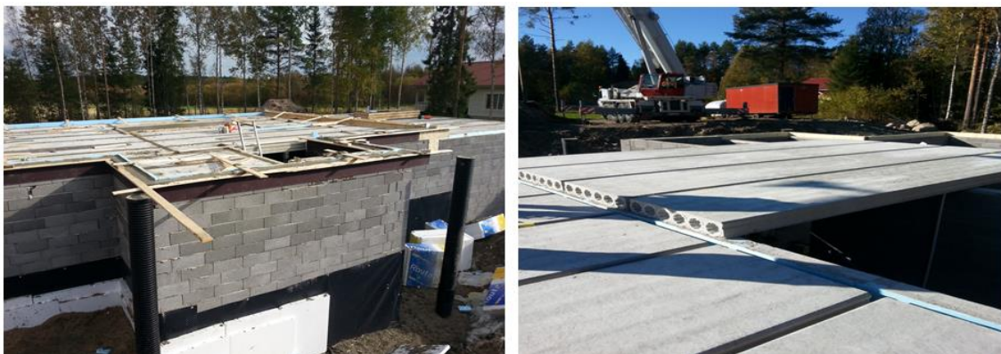
KUVA 1. Alakerran seinärunko ja ontelolaattojen nosto
