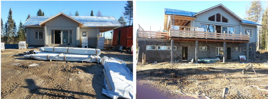
KUVA 3. Ulkoseinien maalaus, vesikaton teko ja ikkunoiden asennus käynnissä
