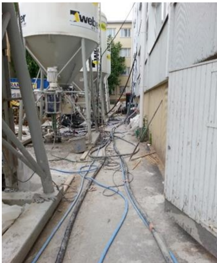
KUVA 3. As Oy Kuninkaankatu 29, sisäpiha LVIS –peruskorjauksen aikana (Räsänen 2014-06-05.)
