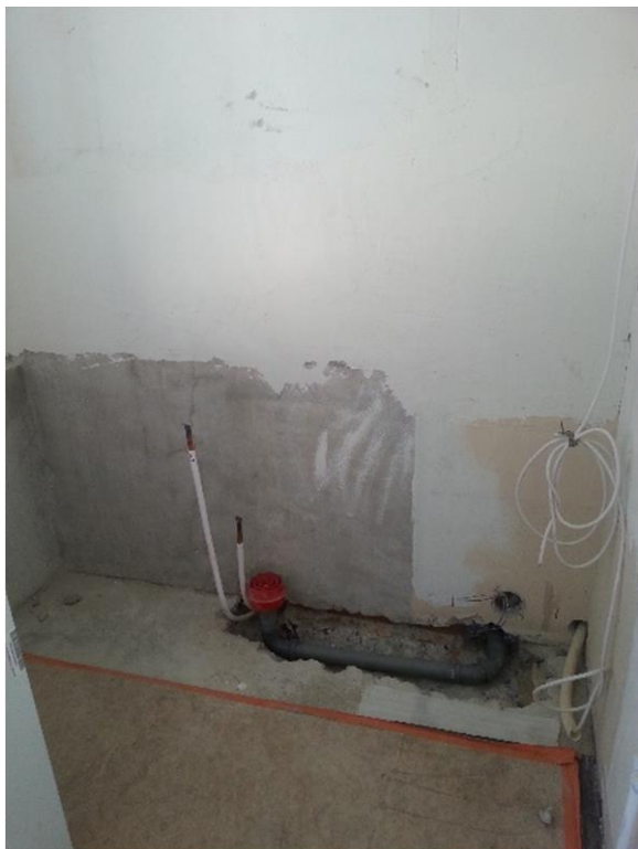
KUVA 6. Purettu keittiö. (Räsänen 2014-06-05.)
