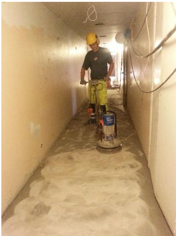
KUVA 13. Lattian hiontatyö (Räsänen, 2014- 06-09.)
