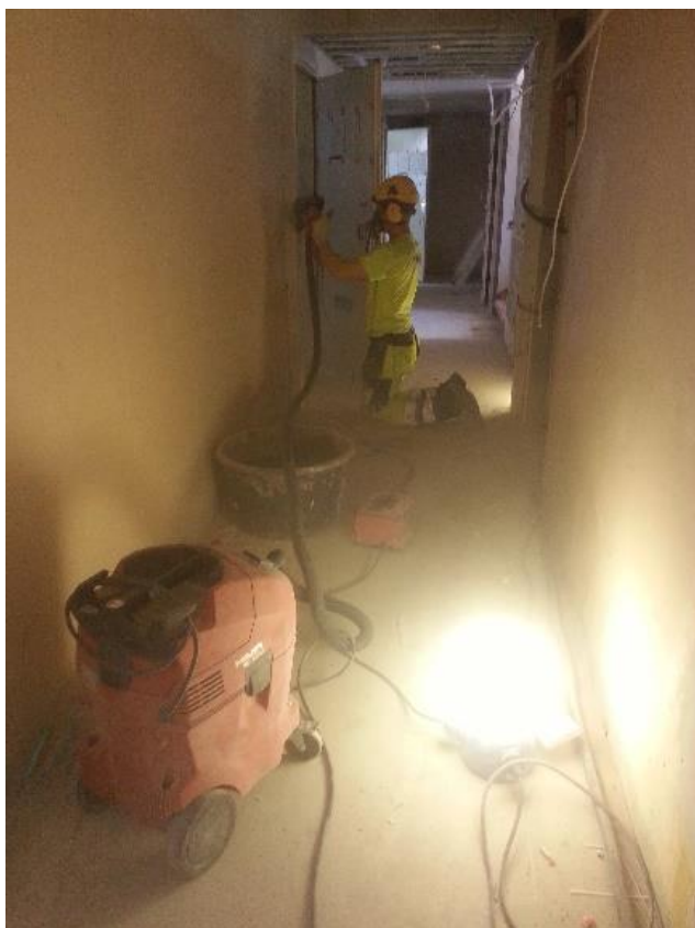
Kuva 14. Seinän hiontatyö (Räsänen, 2014-06-09.)
