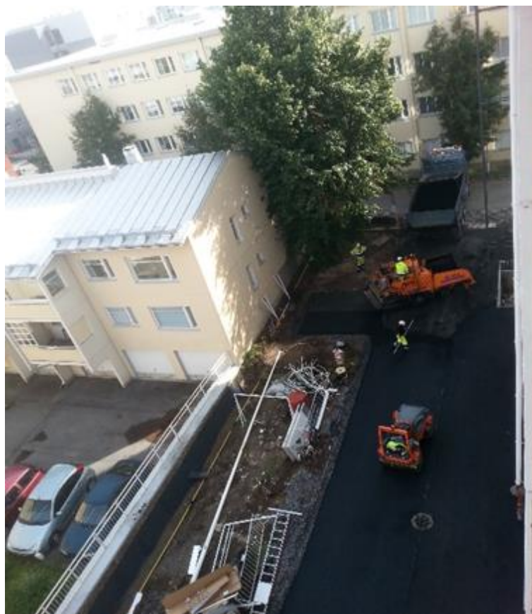
KUVA 12. Pihan asfaltointi, Kuninkaankatu 29 (Räsänen, 2014-07-05)
