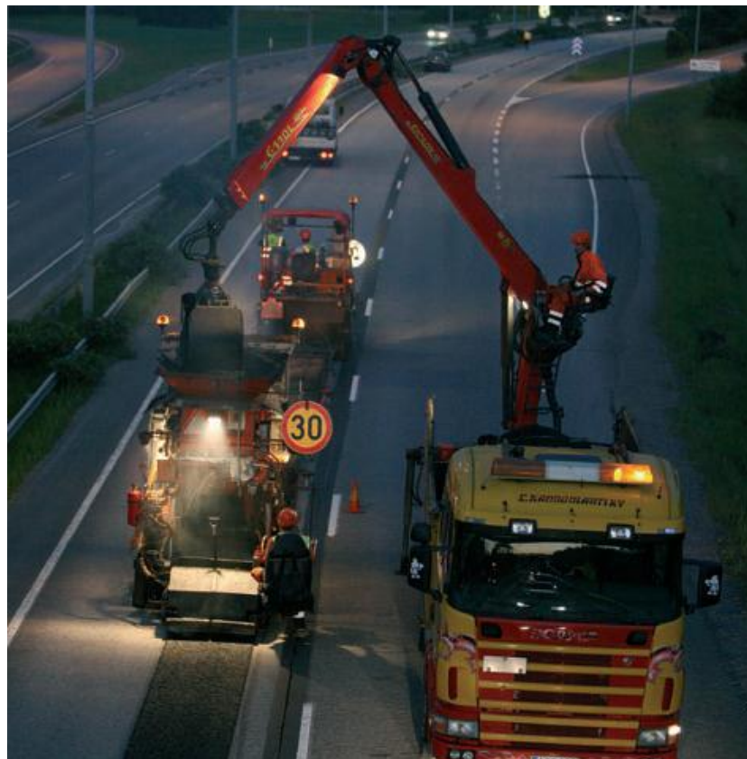
Kuvio 5. Lisämassan syöttö Uraremixer-laitteeseen. (Lemminkäinen 2014b, 2.)
