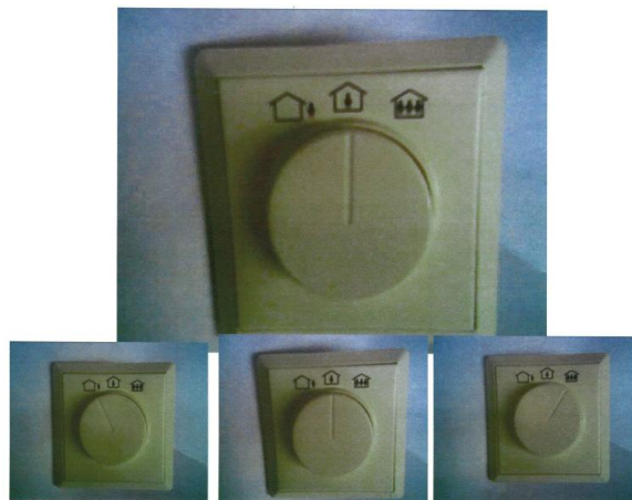
Figur 17, HSVA brytare (Fläkt Woods)
