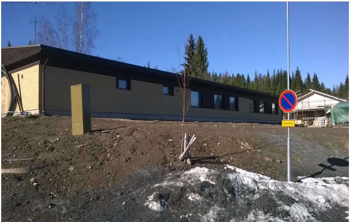
Kuva 2. Rakennus takaa. Kuva Heikki Huotari 2014
