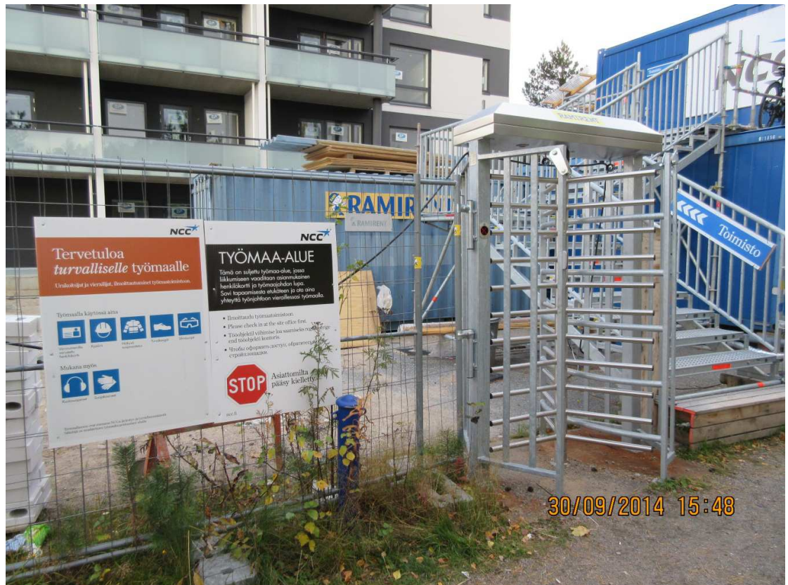
KUVA 4. Kulunvalvontalaite työmaaportilla (Tuomas Varonen, 2014)
