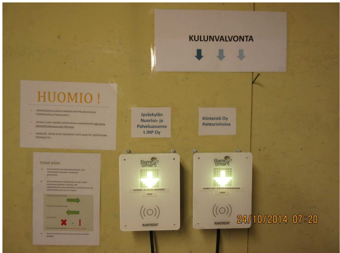
KUVA 3. Kulunvalvontalaitteita työmaalla. (Tuomas Varonen, 2014)
