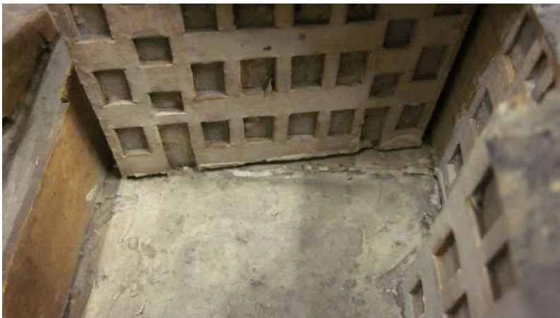
Kuva 32: Irtonainen seinämä (HSch)
