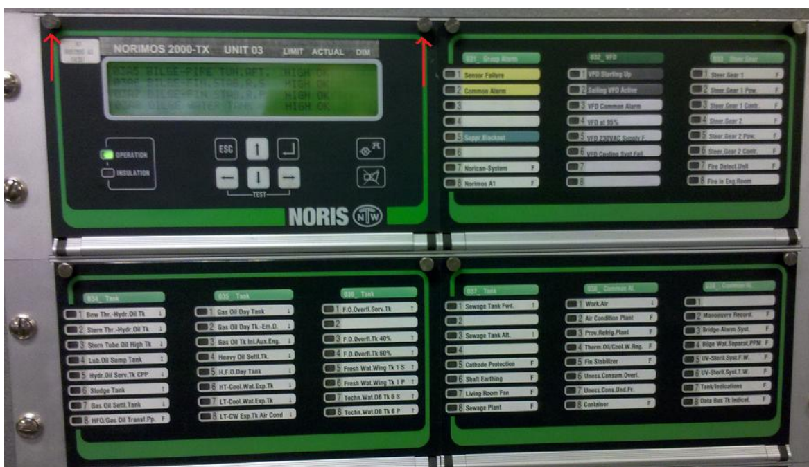
Figur 11. Norimos panel 2000 A03 pilarna indikerar var man öppnar för att byta e-prom. (Foto: Mats Wikman, 2014)
