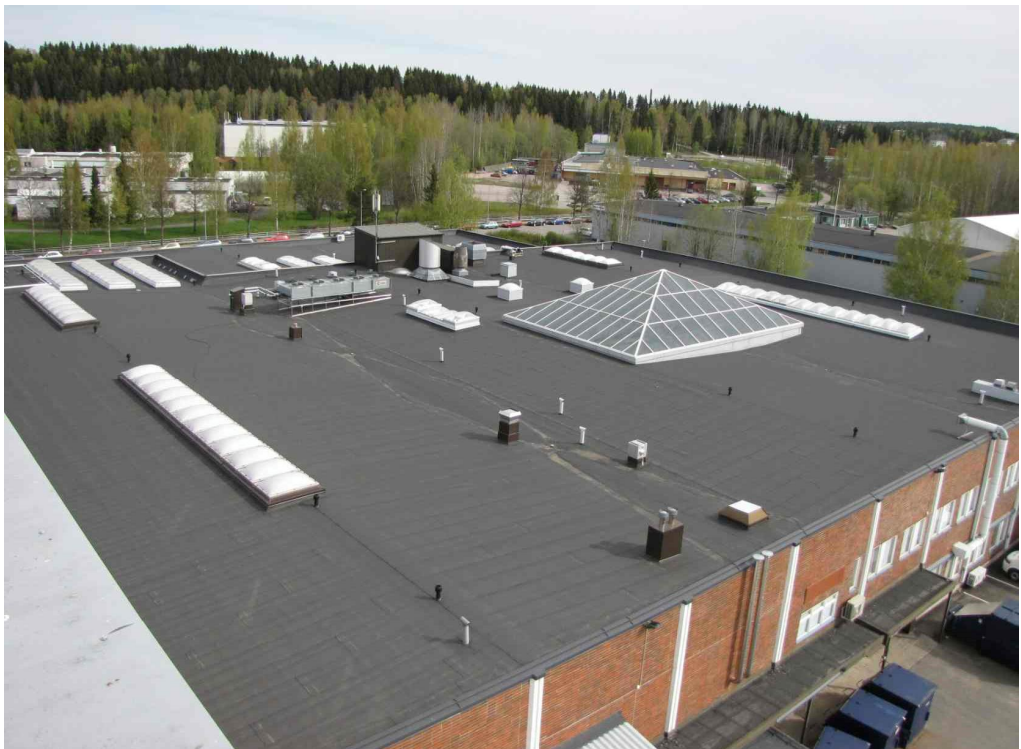
KUVA 8. Näkymä Niemenkadun B-siiven katolle. ”Kilpikonna-aulan” lasitus katon keskiosissa on mitoiltaan noin 18*12 m. Aurinkosähköpaneeleille on riittävästi asennustilaa.
