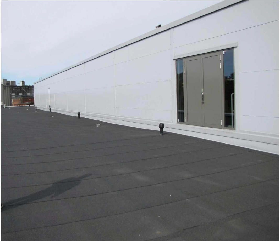
KUVA 6. Niemenkadun D-siiven ylimmän kerroksen teknisestä tilasta katolle johtava ovi
