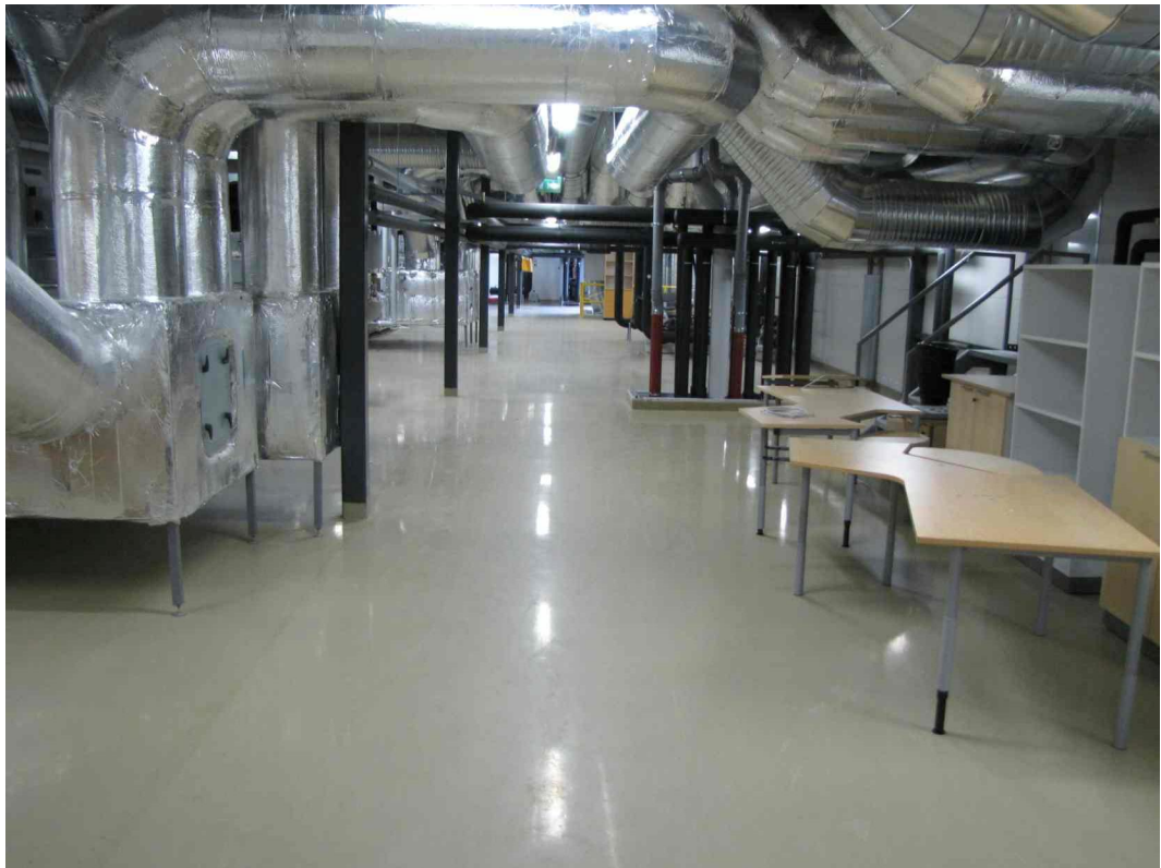
KUVA 5. Niemenkadun D-siiven ylimmän kerroksen teknistä tilaa
