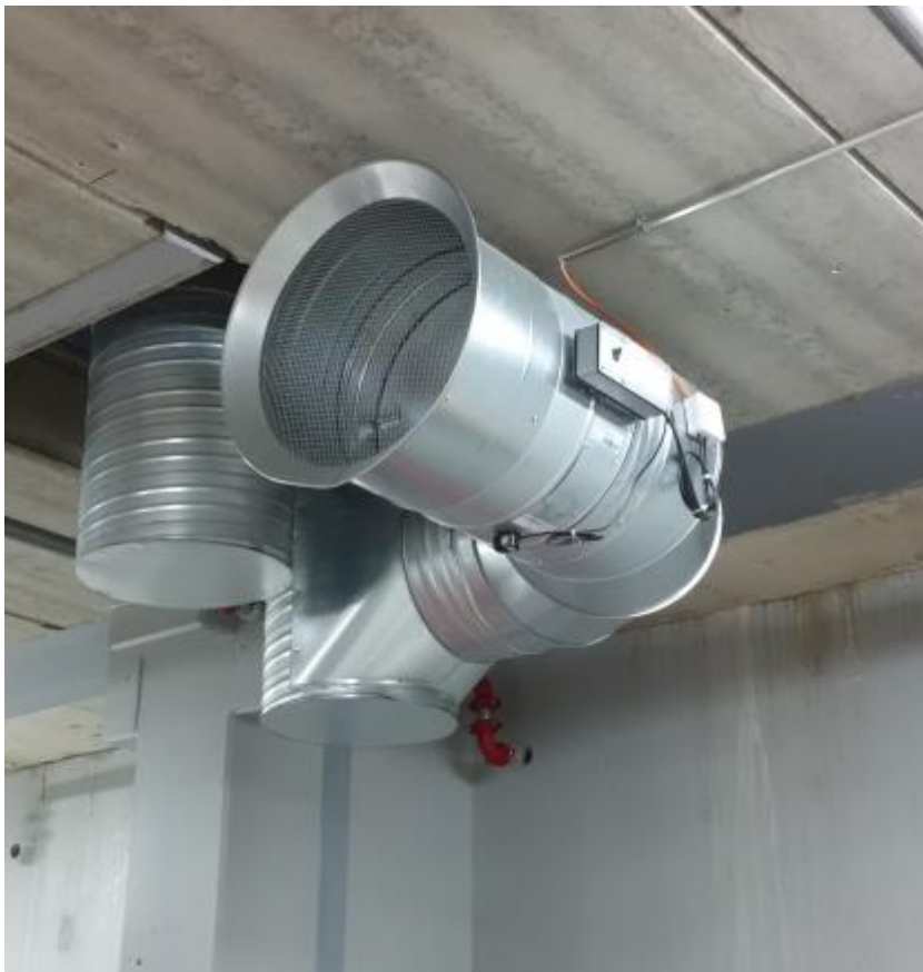
KUVIO 14. Savunhallintapelti einestehtaassa.
