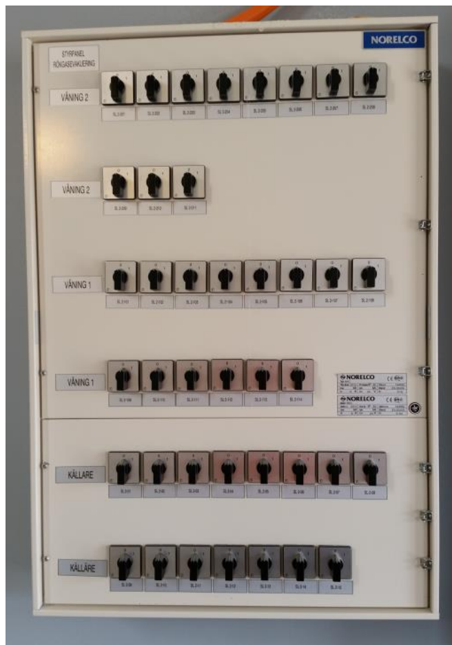
KUVIO 13. Savunpoistojärjestelmän ohjauspaneeli.
