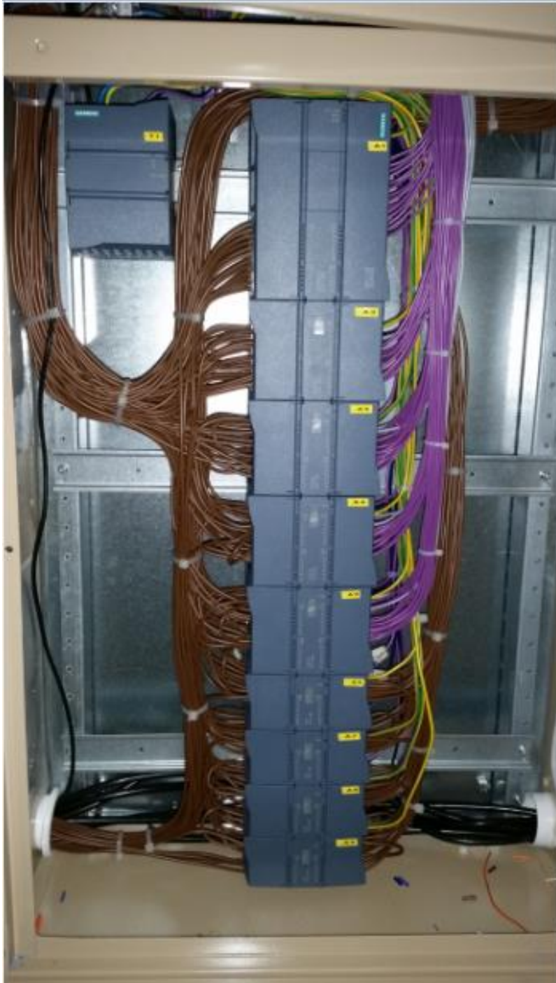
KUVIO 18. Einestehtaan savunpoistojärjestelmässä käytetty logiikka.
