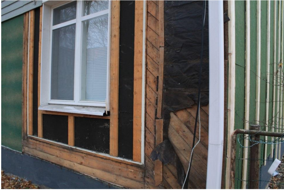
KUVA 5. Rintamamiestalon ulkoseinärakenne puretun laudoituksen alla. Tervapaperi vinolaudoituksen pinnassa
