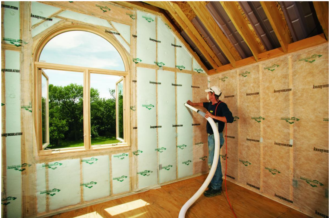
KUVA 14. Knaufin Supafil Frame -eristeen asennus (Supafil Frame: Knauf Insulation. 2013)
