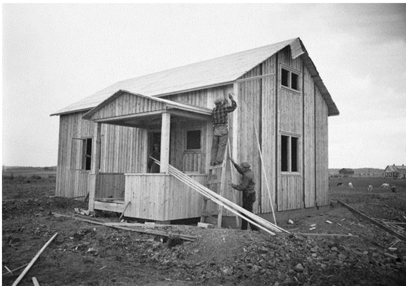
KUVA 1. Suomen valokuvataiteen museon arkistokuvassa rakentajat naulasivat nurkkalautoja 8.9.1940 (Uusia maatiloja pakolaisille: Uusi Suomi. 2008)
