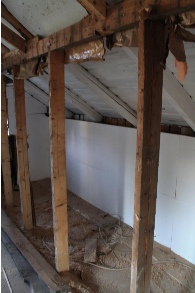
KUVA 10. Purettu kantava väliseinä
