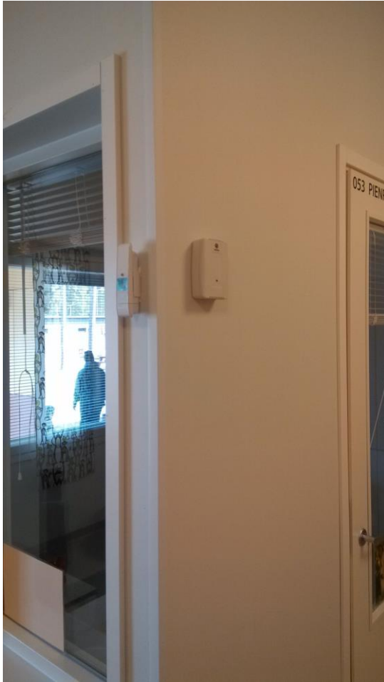
Kuva 11: Wirepas CO 2 -anturi ryhmän 2 ryhmähuoneessa (oikealla)
