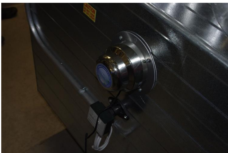
Kuva 5: Ensimmäinen sairaalan ilmastointikoneen REME-kennoista
