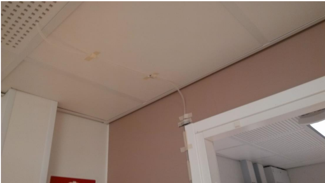
Kuva 15: Ilmaletkujen vienti ovilistoja pitkin.
