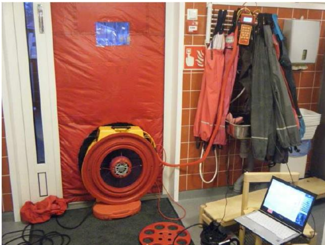
Kuva 2: Ilmatiiveysmittauksessa käytetyt tarvikkeet (Uusitalo, S. 2013, 34).
