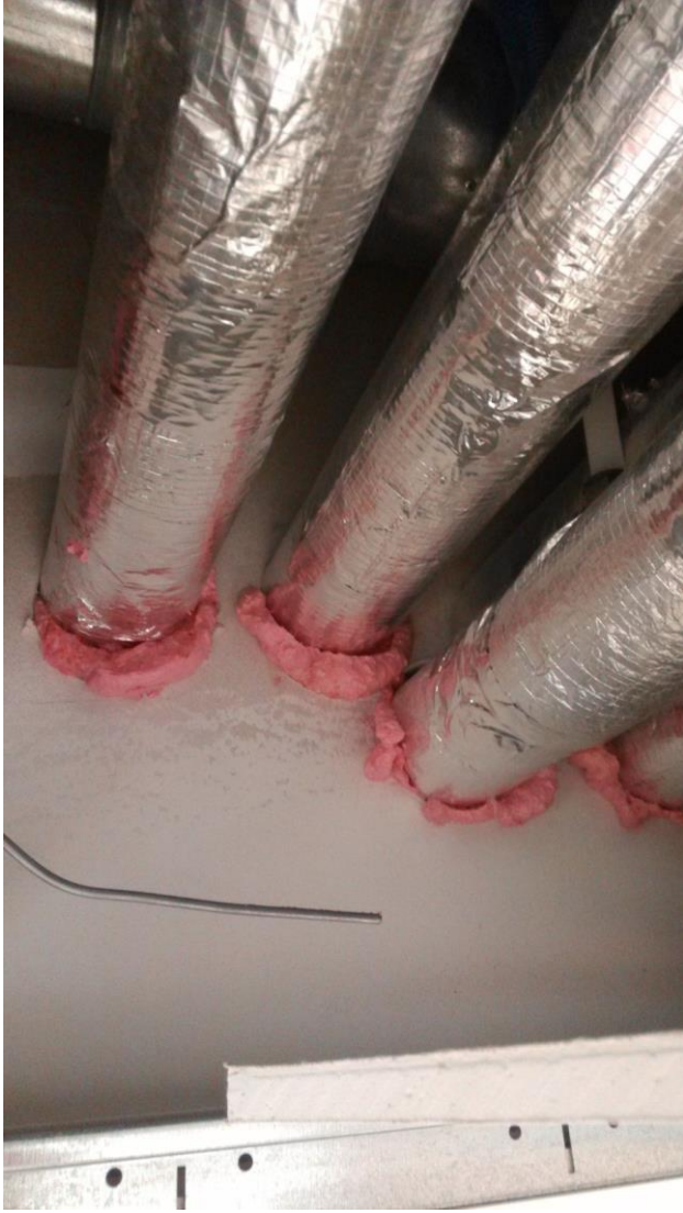
Kuva 3: Päiväkodin ilmastointikanavien läpivientien tiivistykset
