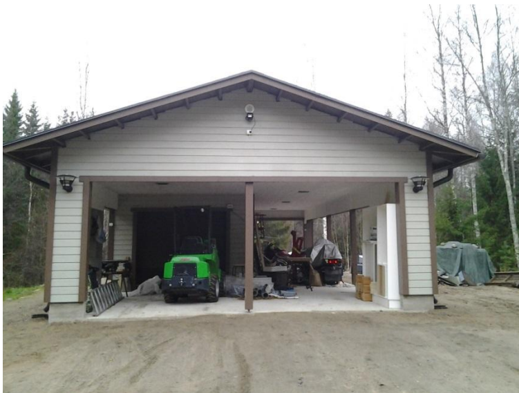
KUVA 1. Mittauskohteena oleva autotalli
