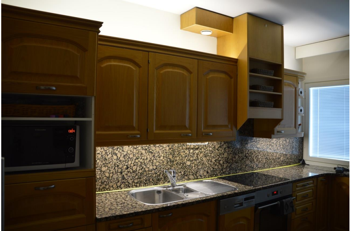
Kuva 11. Keittiön valaistus led-nauhavalaisimilla toteutettuna.
