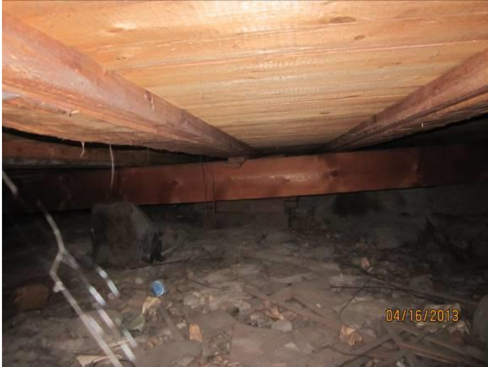
Kuvio 4 Alapohjan tuuletustila eteläpuolelta
