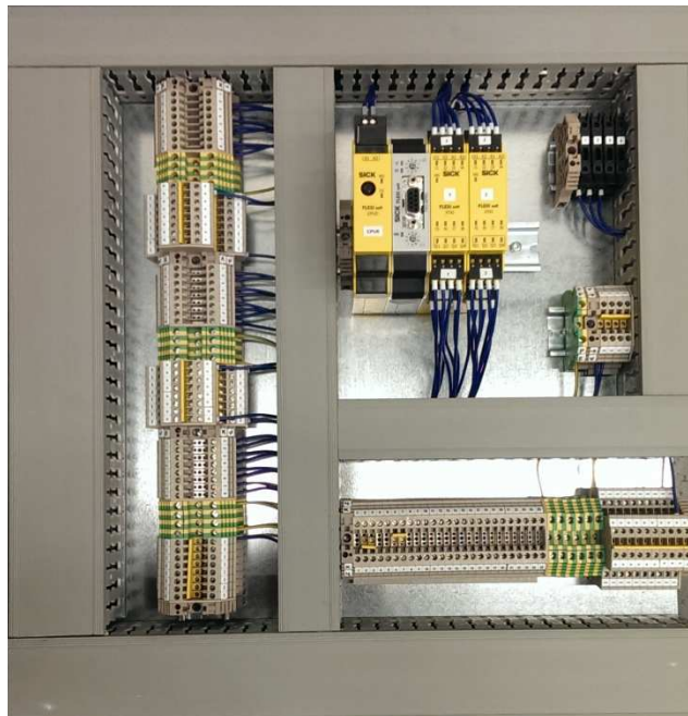
Kuva 8. Elevaattorin keskuksen pohjalevy valmiina (Kuva A. Kaurto 2014.)
