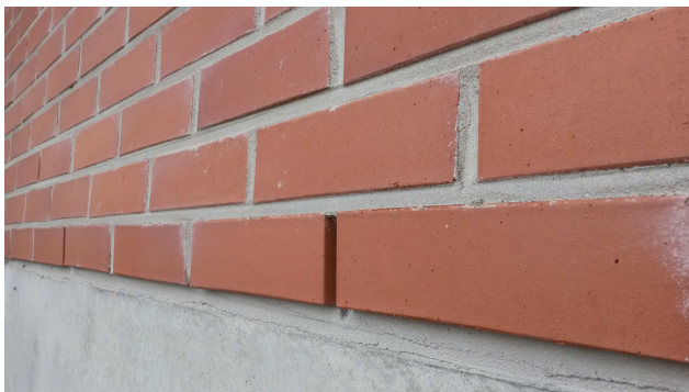
KUVIO 7. Tiilimuurattu julkisivu.
