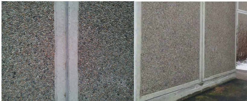
KUVIO 2. Pesubetoninen sandwich-elementin ulkokuori.
