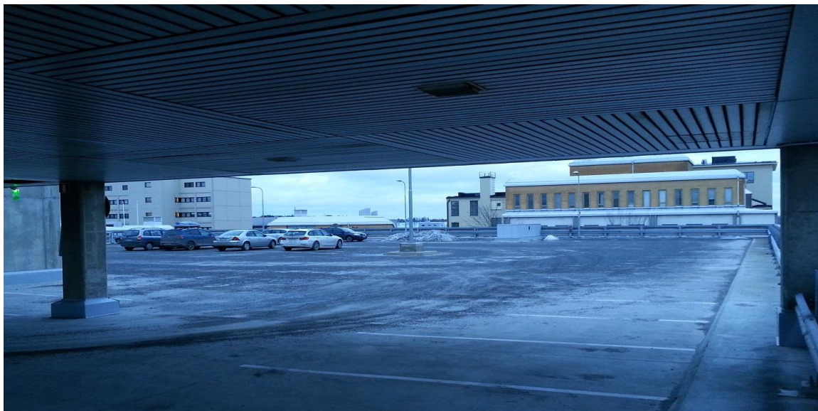
Kuva 3. Katettu alue pysäköintikannen länsireunassa. Kuva Ville Väisänen
