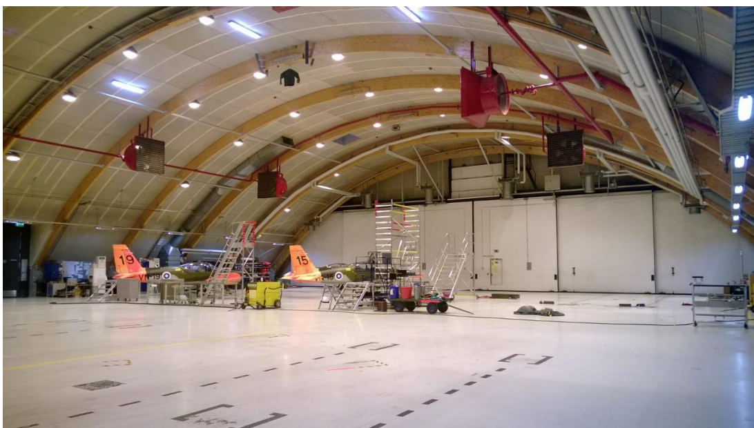
Kuva 9. Mittauspäivänä otettu valokuva LEKOhallista.
