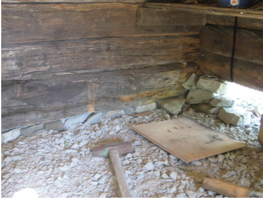
Kuvio 10. Paja nostettiin kivien päälle ja välit täytettiin.
