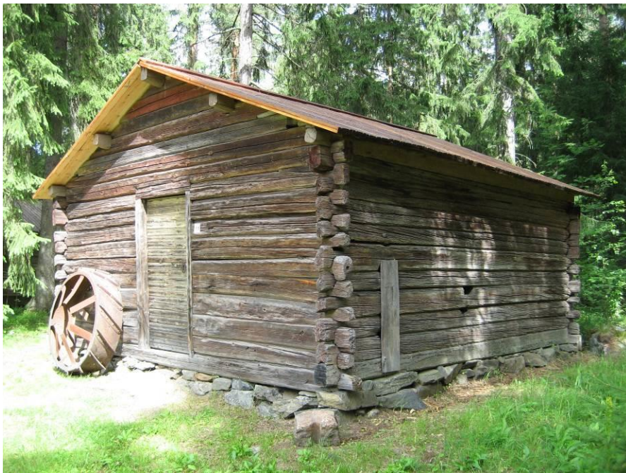
Kuvio 1. Liinamaan pihapiirin paja on tyypillinen perinteinen paja. Luukulla suljettava ikkuna-aukko sijaitsee rakennuksen toisella sivuseinällä.
