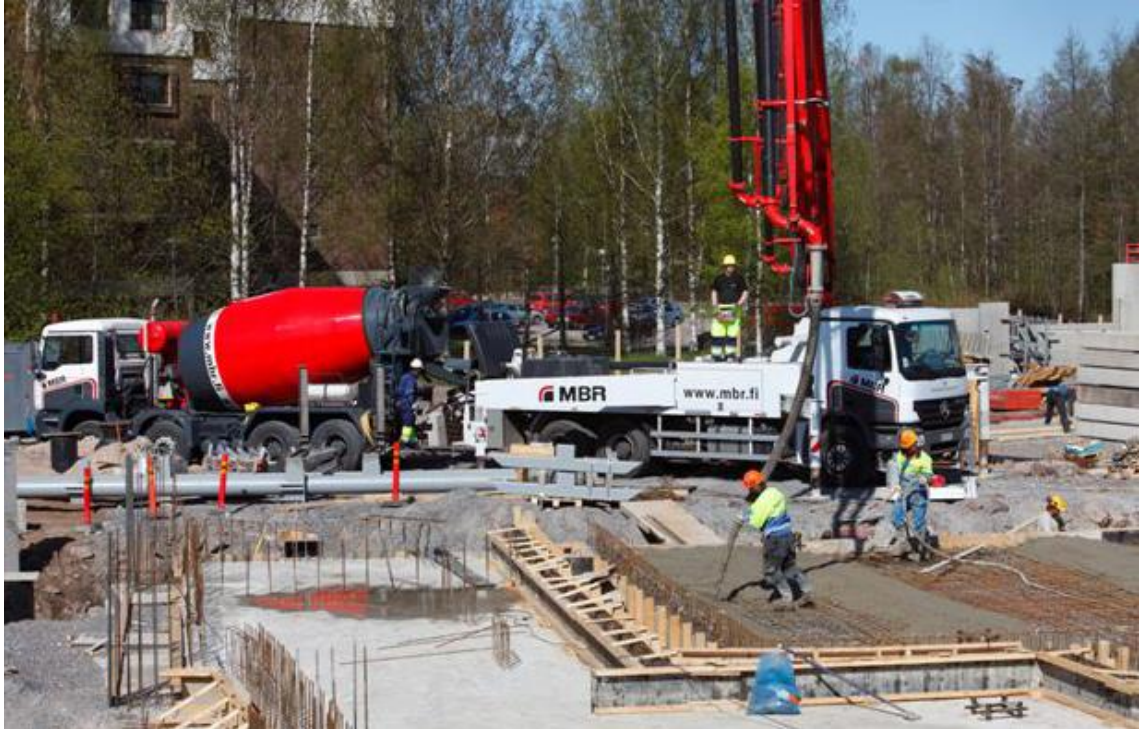
Kuva 1. Lattiavalutyö käynnissä.
