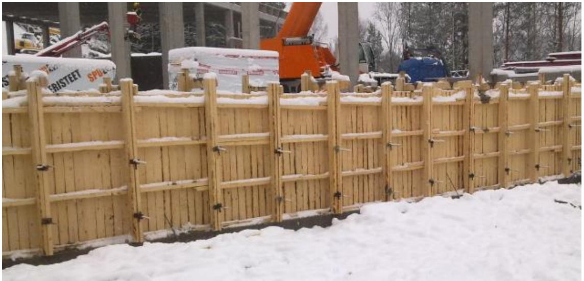
Kuva 4. Kappaletavarasta muotitettu tukimuuri.
