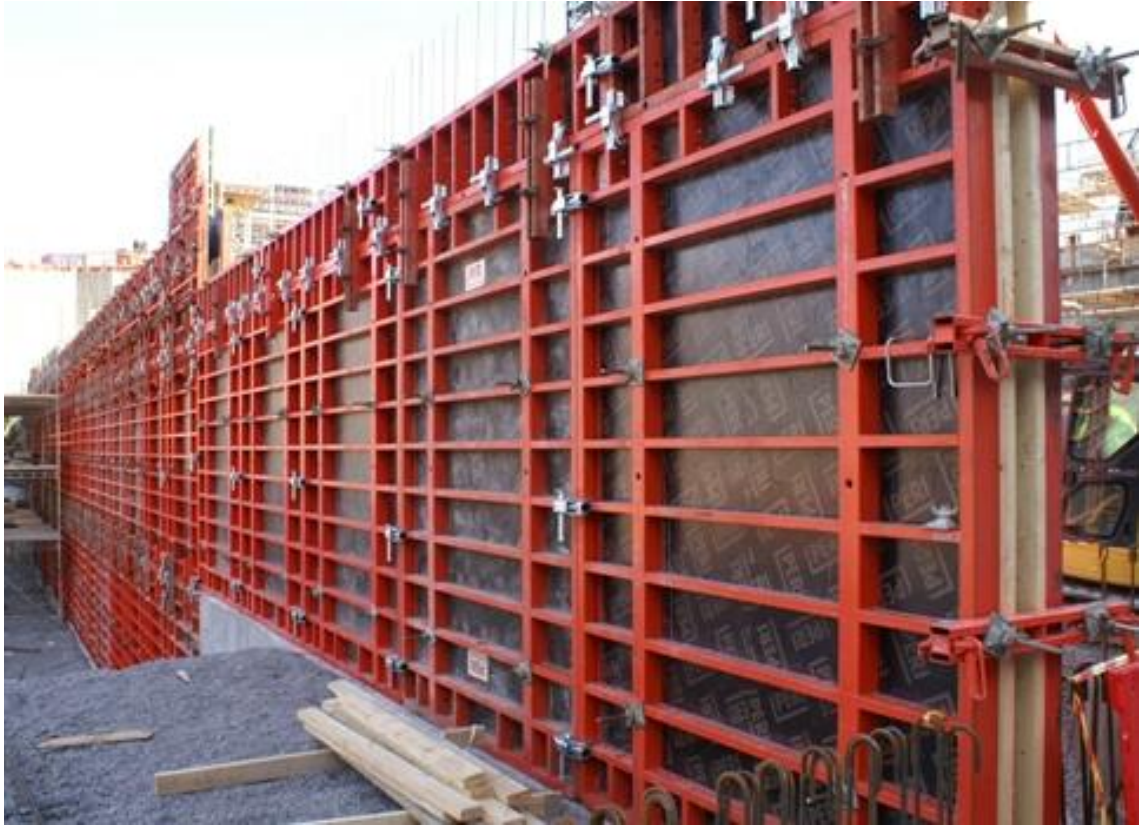
Kuva 3. Peri -järjestelmämuottikalustolla laudoitettu seinä.
