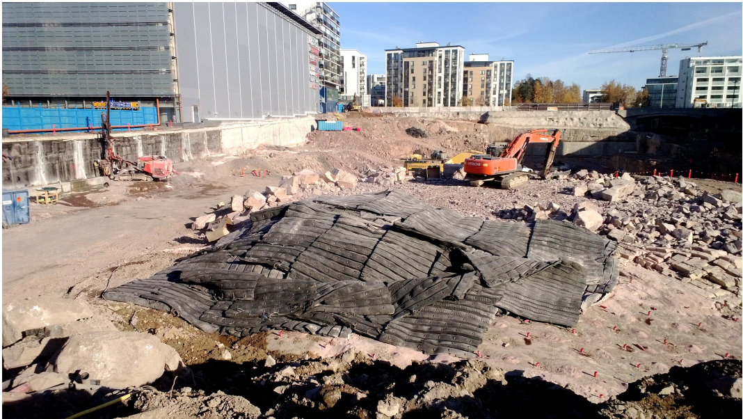
Kuva 3. Räjähdysen jälkeen. Vain ylin mattokerros on liikahtanut alimpien pysyessä paikallaan. Kuva on otettu Matinkylän metrokeskuksen työmaalta.
