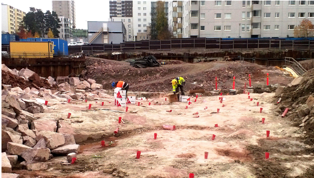
Kuva 2. Noin 100 m 2 :n panostettava kenttä Matinkylän metrokeskuksen työmaalla
