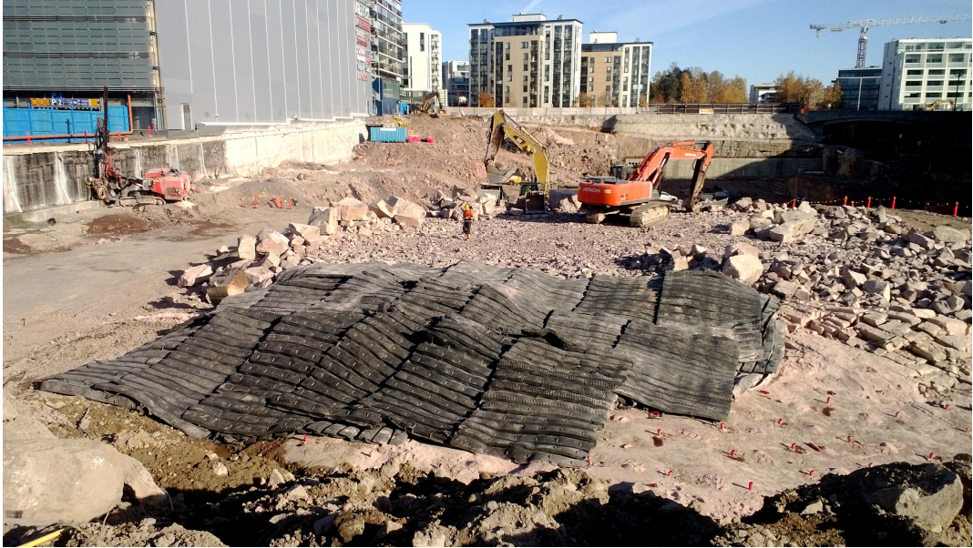
Kuva 2. Oikeaoppinen räjäytettävän kentän peitto. Limitystä ulottuu reilusti kentän ulkopuolelle ja mattoja on panostukseen nähden riittävästi. Tässä tilanteessa mattoja on 3 kerrosta. Kuva on otettu Matinkylän metrokeskuksen työmaalta.
