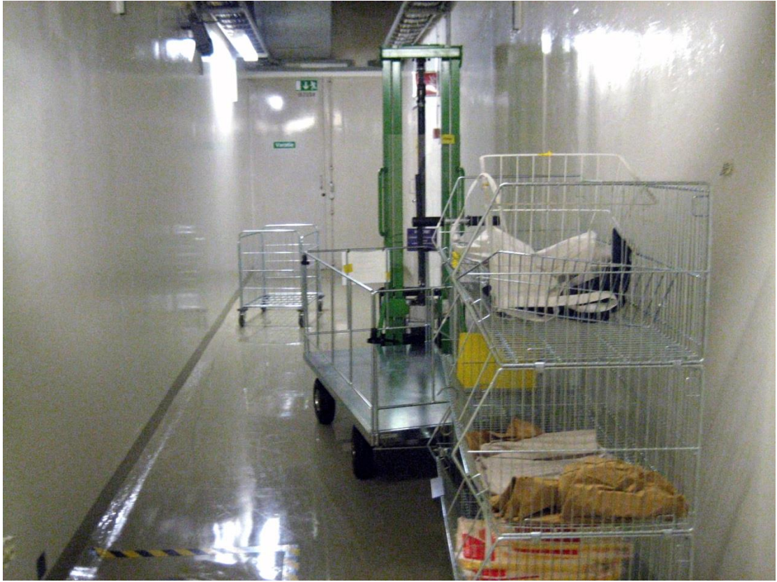
Kuva 7. Varastoitua tavaraa poistumistien läheisyydessä
