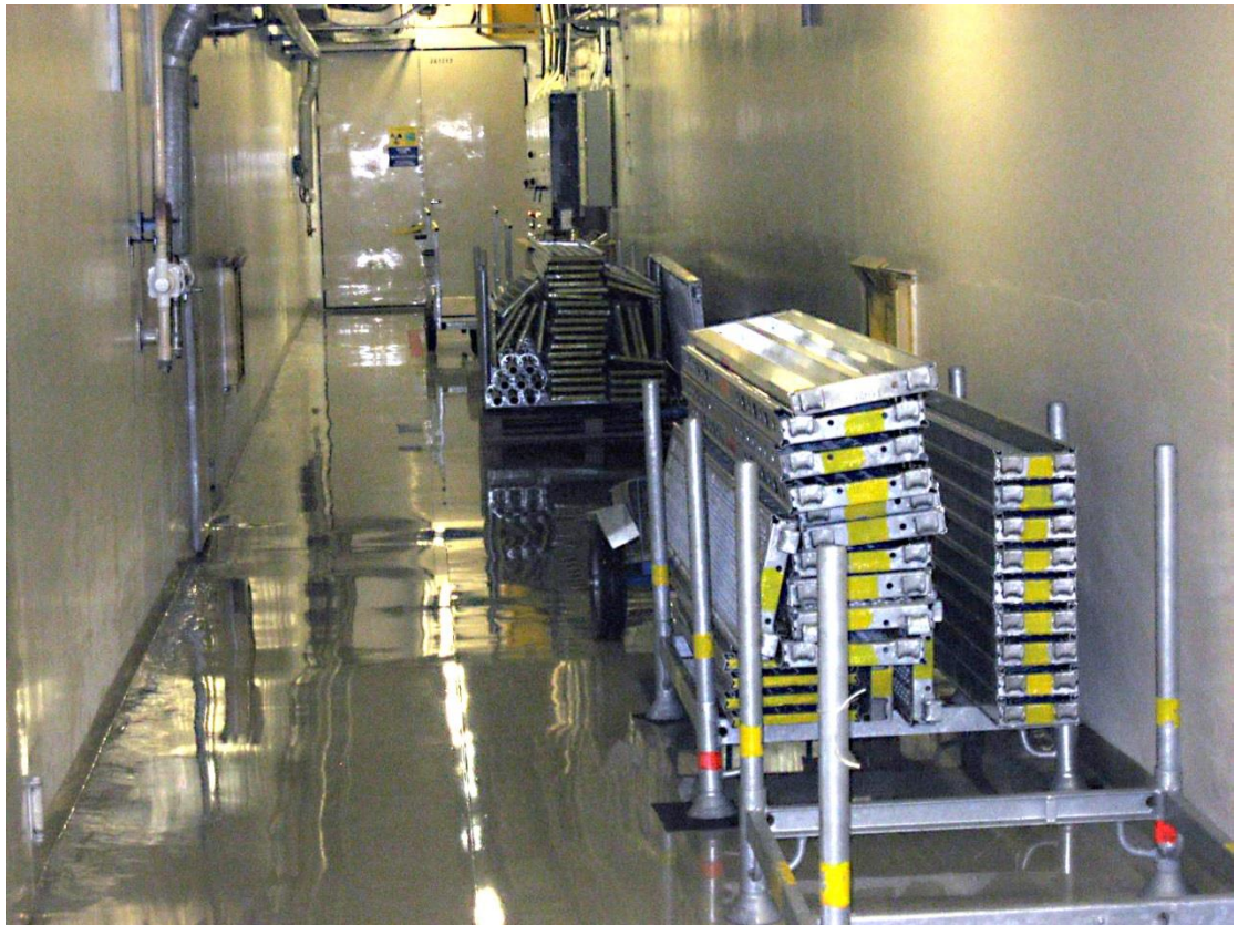
Kuva 4. Telineosia varastoituna käytävällä
