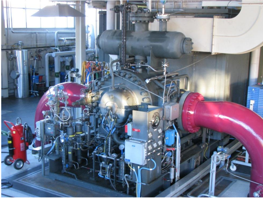
Kuva 9 Kompressorista. Kompressoria pyörittävä turbiini taustalla koteloidussa kabiinissa. (6.)
