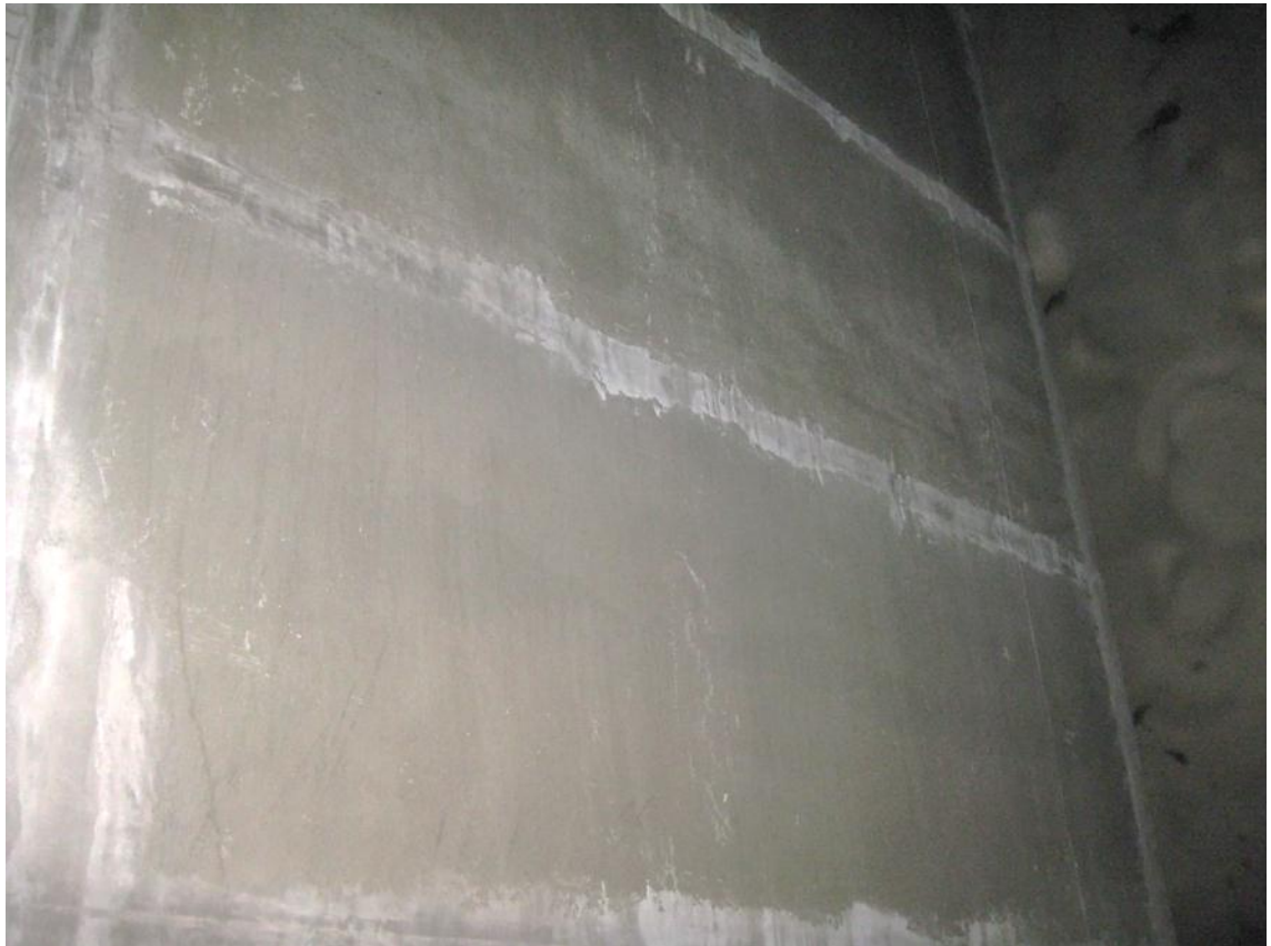
KUVA 7. Valmis elementtirakenne P-Hämpin kiuussa, oikea reuna rajautuu kallioon
