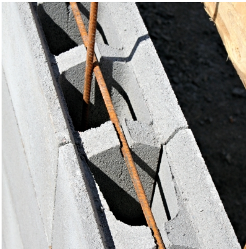
KUVA 8. Valuharkon raudoitusta (HB-Betoniteollisuus Oy)
