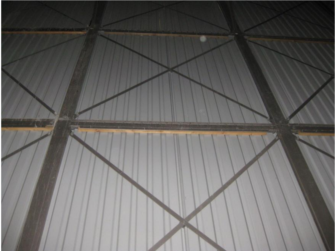
KUVA 11. Valmis teräsrakenne P-Hämpin kuilussa
