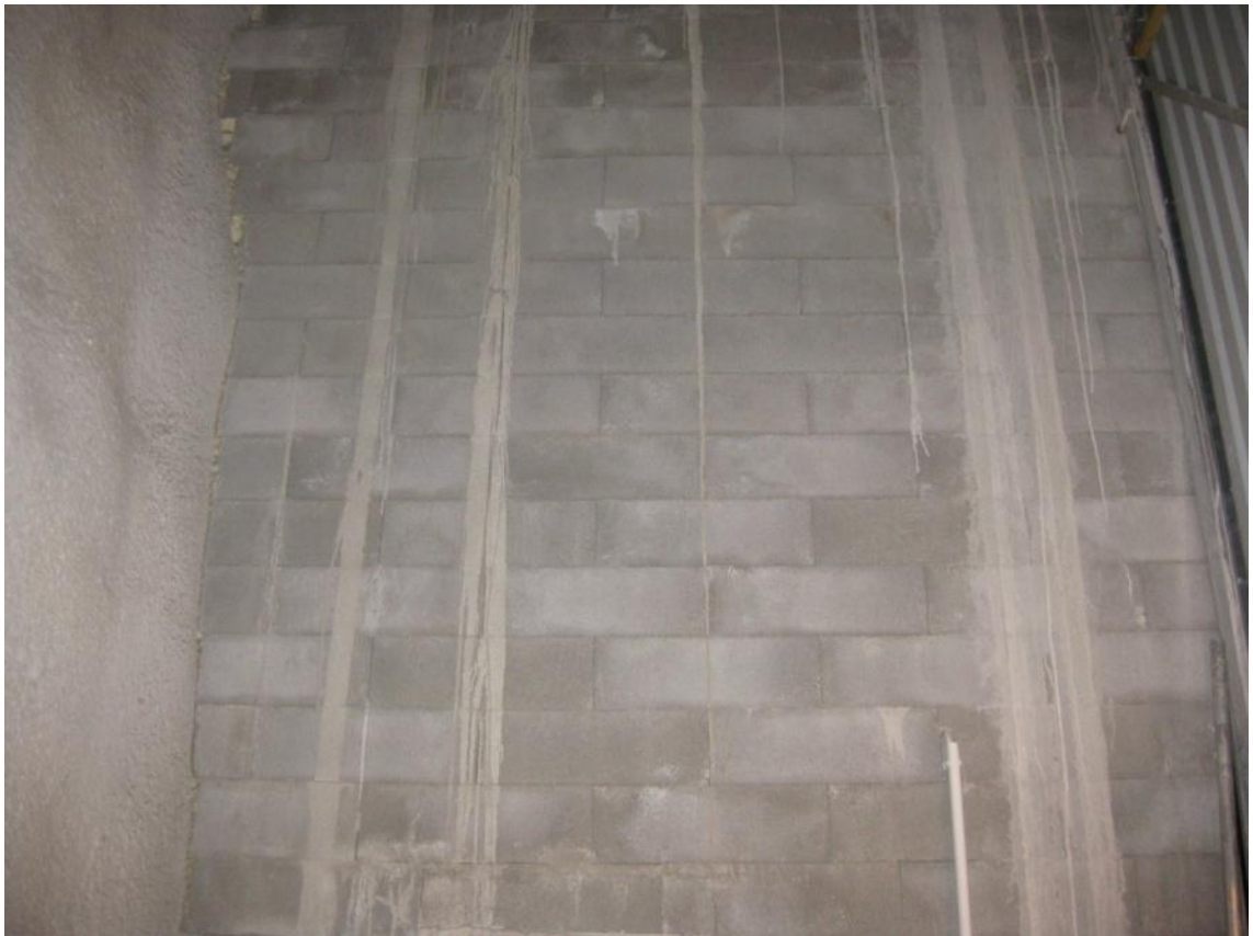
KUVA 9. Valmis valuharkkorakenne P-Hämpin kuilussa, vasen reuna rajautuu kallioon
