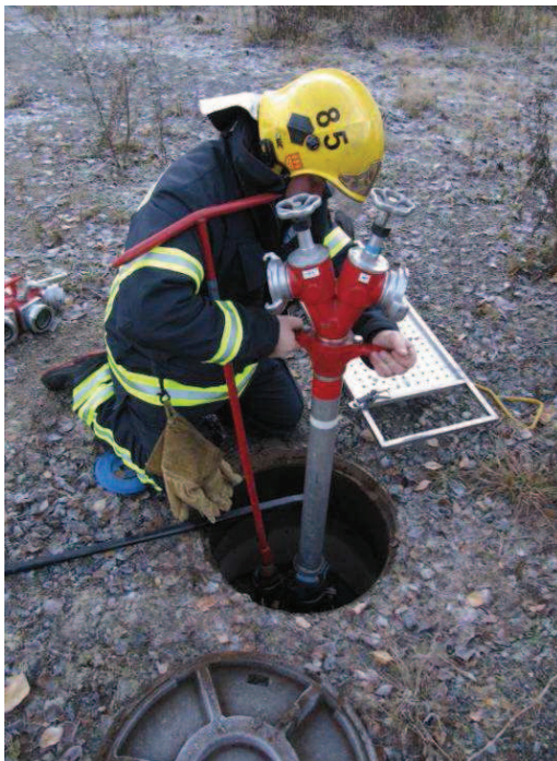
Kuva 6. Palomies tekemässä maapalopostiselvitystä. Menossa pystyputken asennus.
