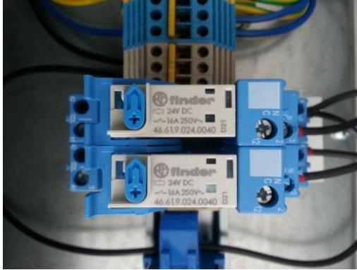
KUVA 16. Välireleet (Kuva: Kare Rantanen 2013)
