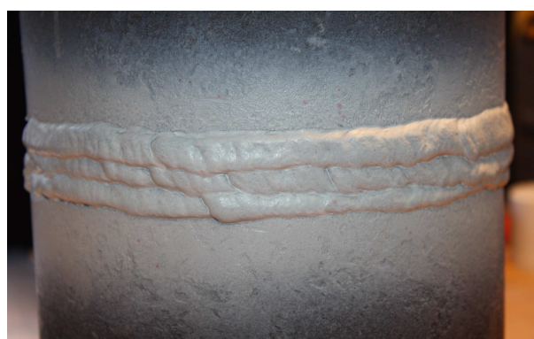
Kuva 2. Putki 2:n hitsi
