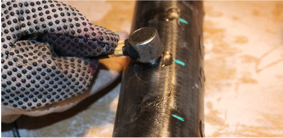
Kuva 4. Putken seinämäpaksuusmittausta ultraäänellä (nollaluotausta).
