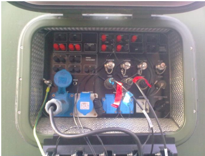
Kuva 23. Puolustusvoimien ajoneuvon kytkentäpaneeli.
