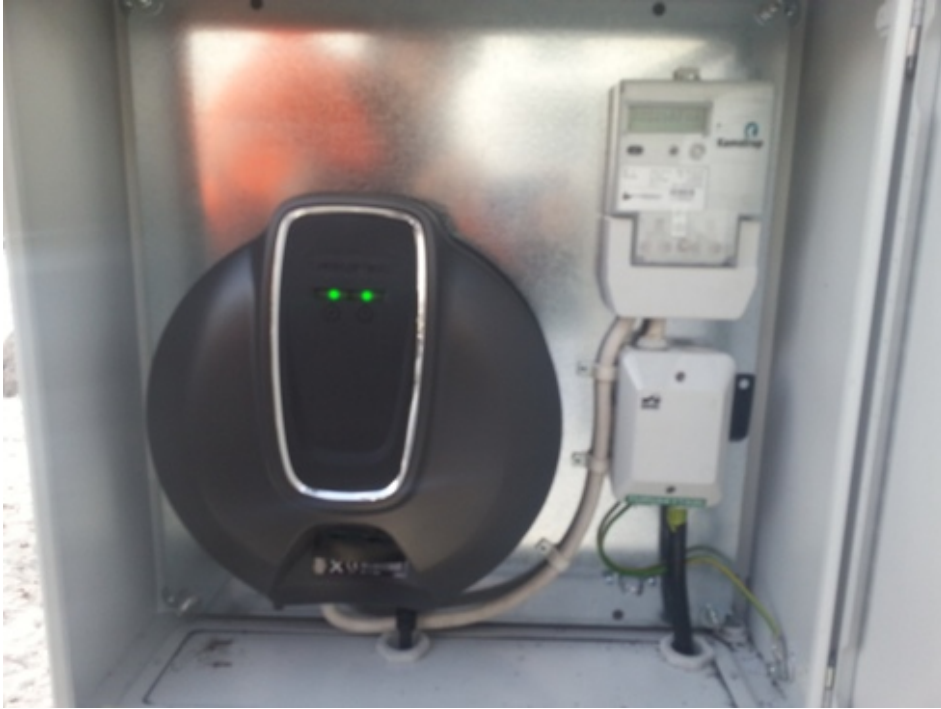
KUVIO 11. Opel Amperan kiinteästi asennettava yksivaiheinen 16 A:n latausase- ma, Oy Herrfors Ab. Lataustapa 3.
