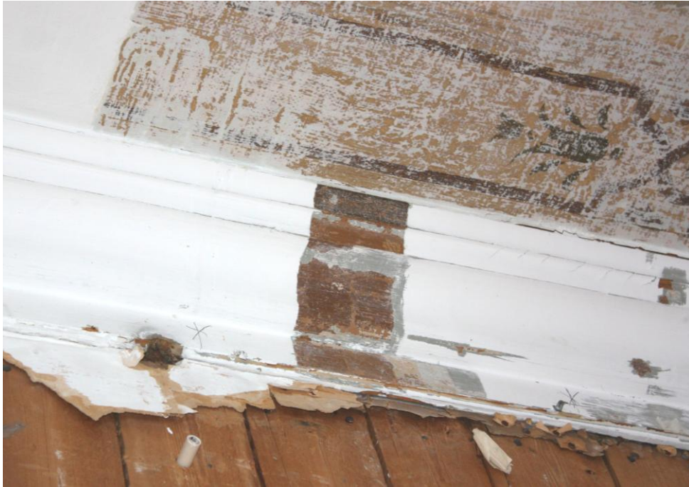
Kuva 11. Alakerran konttorihuoneen holkkalista koostuu kolmesta osasta (Niinipuu 2013).
