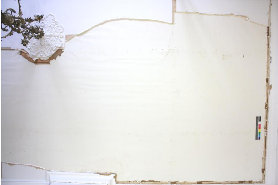
Kuva 8. Levytyksen alla oleva alkuperäinen kattopinta ennen tutkimuksen aloittamista (Niinipuu 2013).
