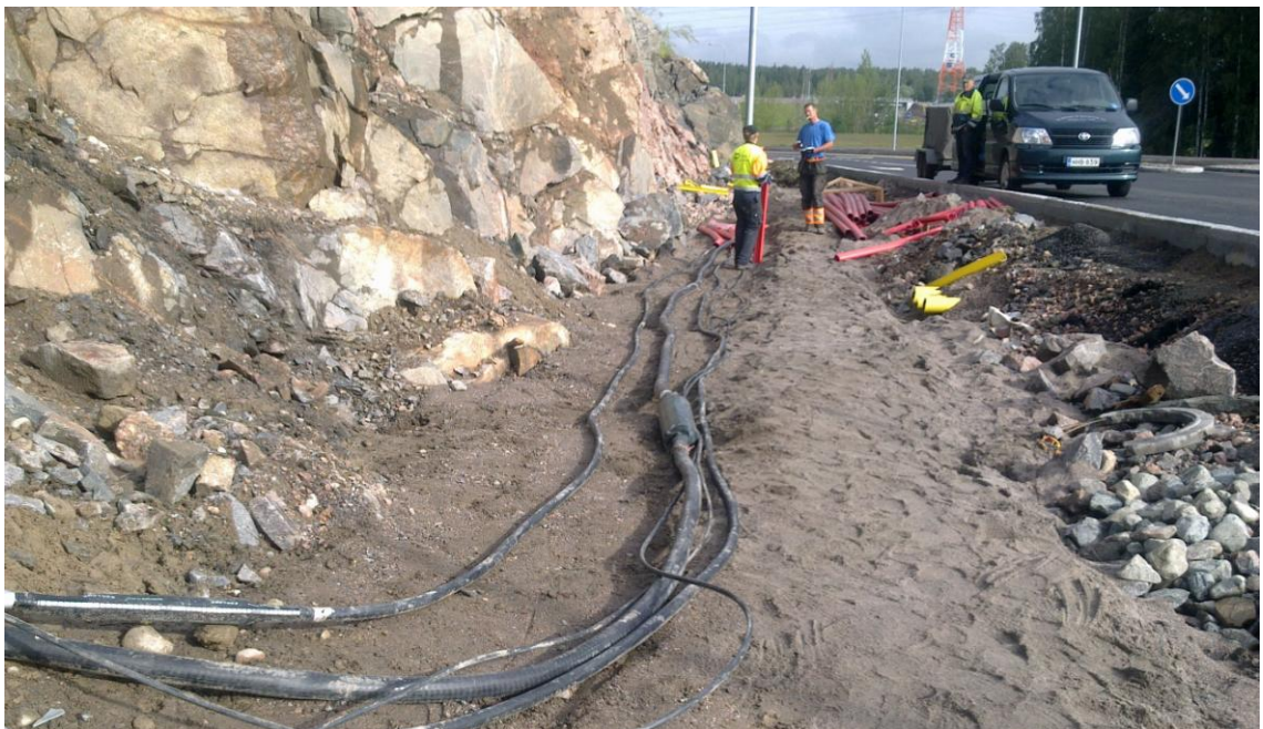
Kuva 3. Yksikköhinta-urakoitsija suojaamassa kaapeleita
