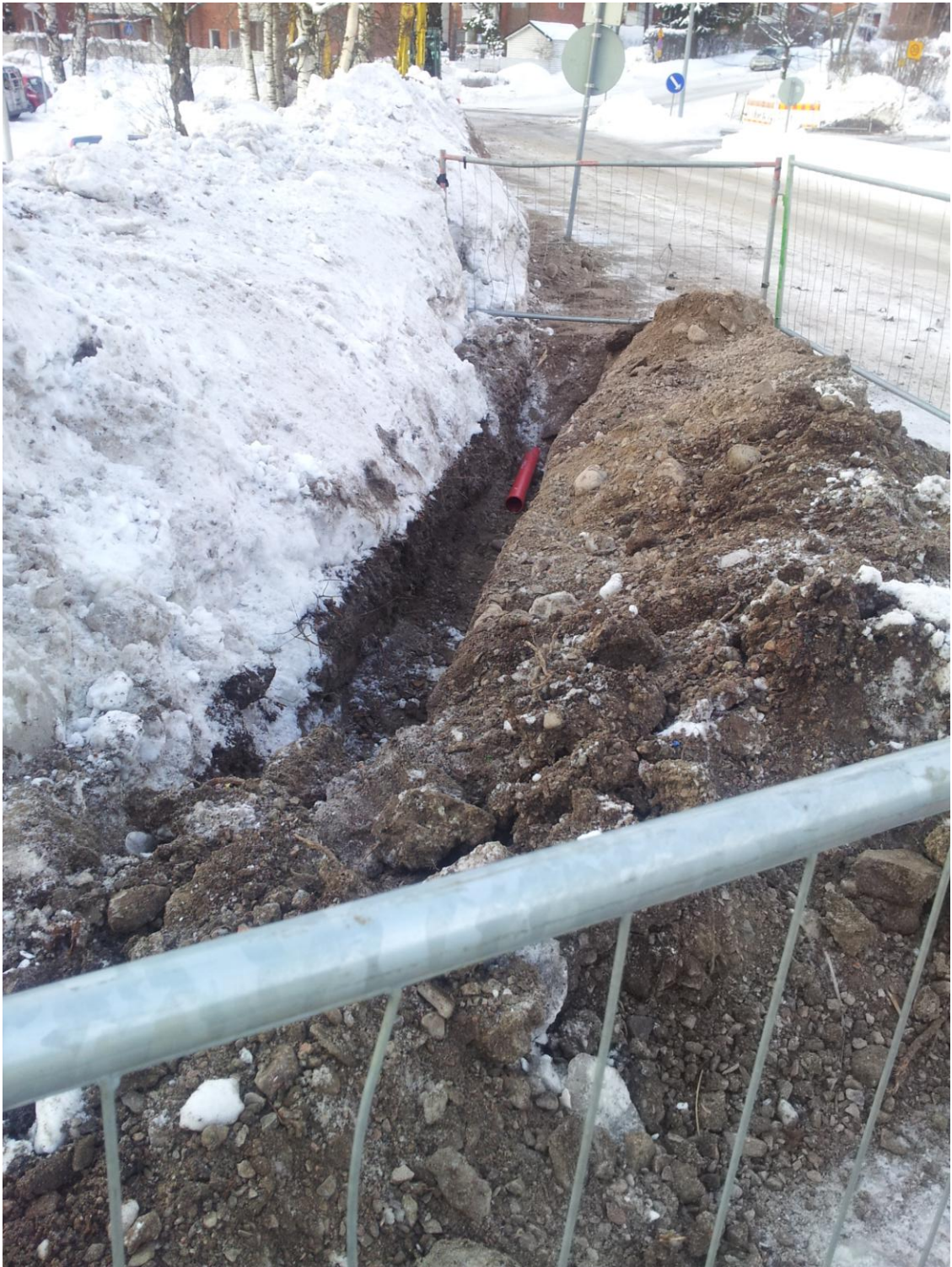
Kuva 2. Uutta putkitusta talvella
