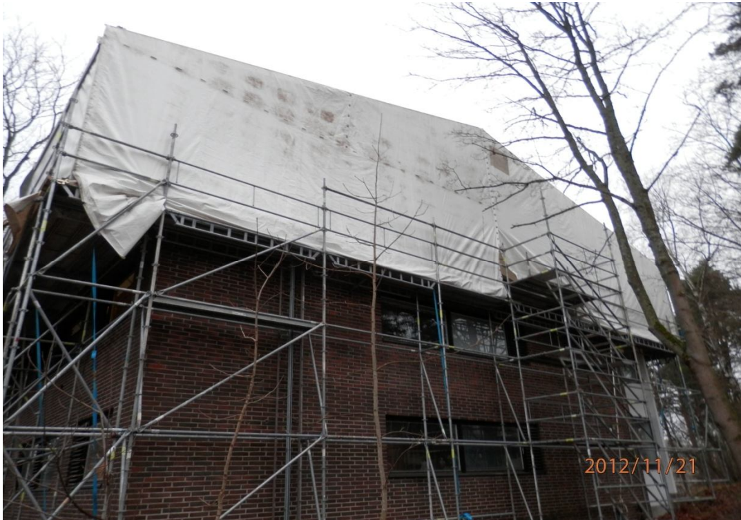
Kuva 6 Rakennuksen ympäri kiertävät telineet, joiden päälle on pystytetty työnaikainen teltta
