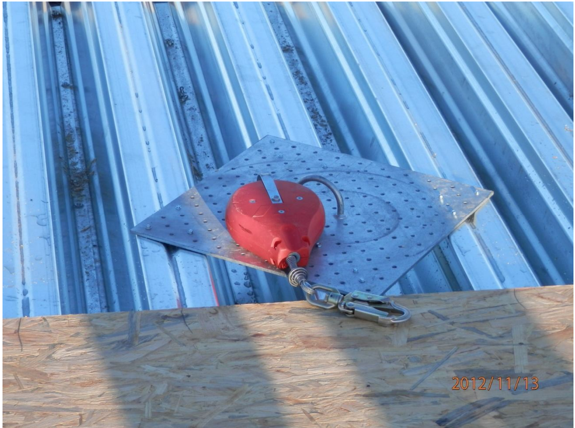
Kuva 10 Kelatarrain ja profiilipeltiin kiinnitettävä väliaikainen pollari
