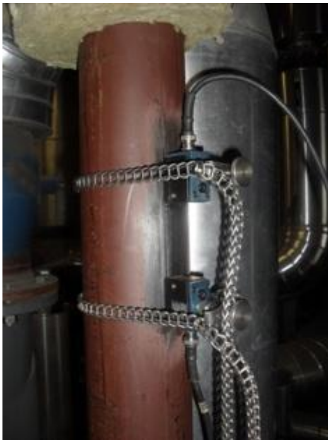
Kuva 5.1.3. Ultraäänimittarin mittaussanturit (Olli-Pekka Vanhala)
