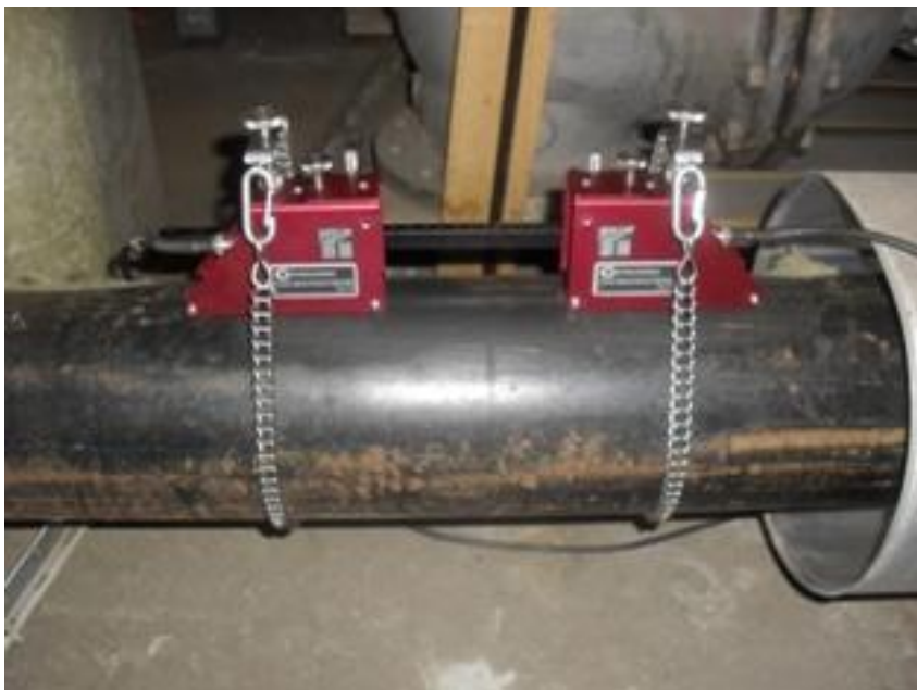
Kuva 5.1.2. Ultraäänimittarin mittausanturit (Olli-Pekka Vanhala)
