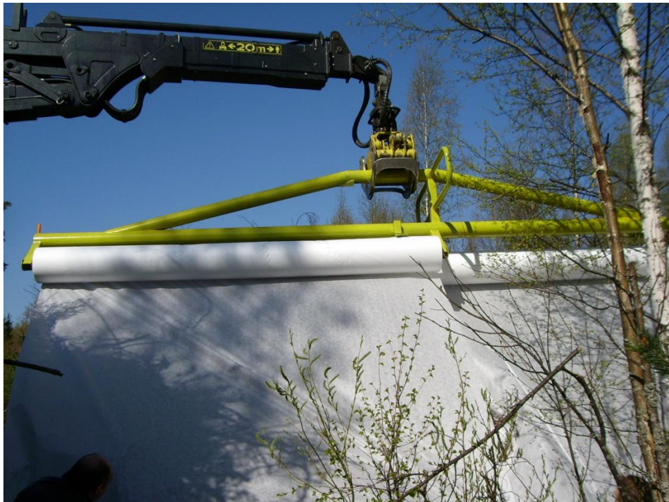
Kuva 2. Laitteen kokonaisleveydeksi saadaan lähes 6 metriä levityslaitteen avulla
