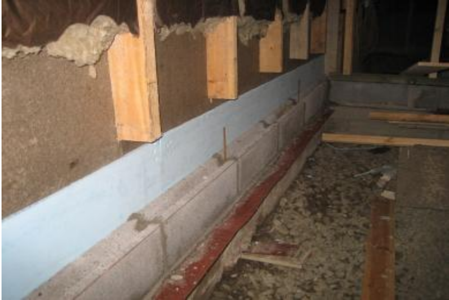
Kuva 7. Harkkojen väliin injektoidut kierretangot alasidepuun kiinnitystä varten
