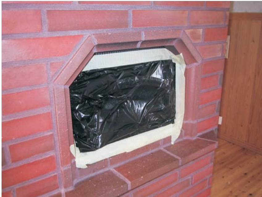
Kuva 1. Takan luukun tiivistys (RT 80-10974,2009, 11).
