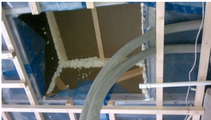
Kuva 19. Jäähdytyslaitteiston asennussyvennys.
