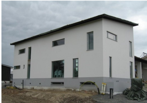
Kuva 39. Villa Ilo, Tampereen asuntomessut
