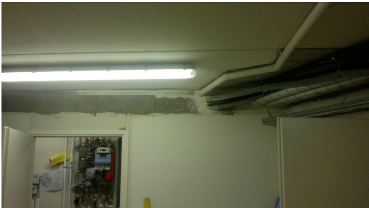
Kuva 27. Kuvan 26 tekninen tila kuvattu autotallista päin. Teknisen tilan läpiviennit tiivistettiin ja autotalli eristettiin tiiveysmittauksen ulkopuolelle.
