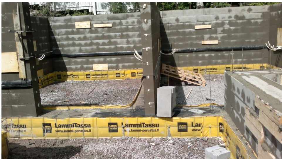
Kuva 29. Ilmansulku- ja radonkaistan asennuskuva
