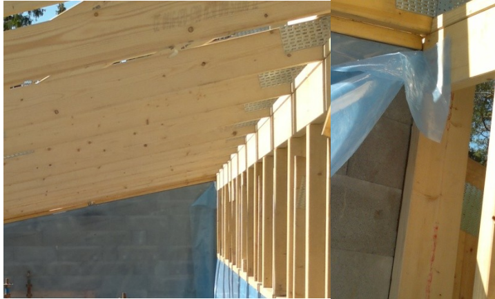
Kuva 18. Kahden eri kattorakenteen liitos.
