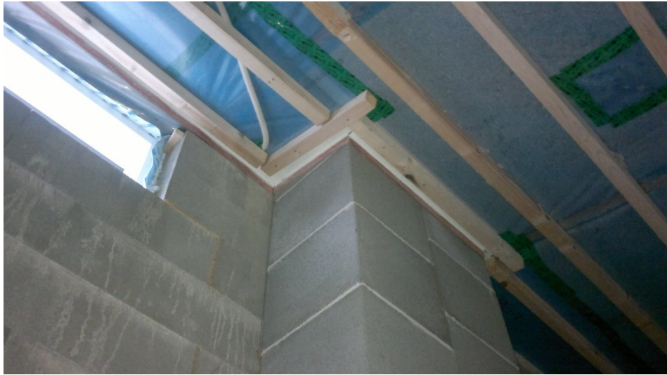
Kuva 28. Hormin tiivistys
