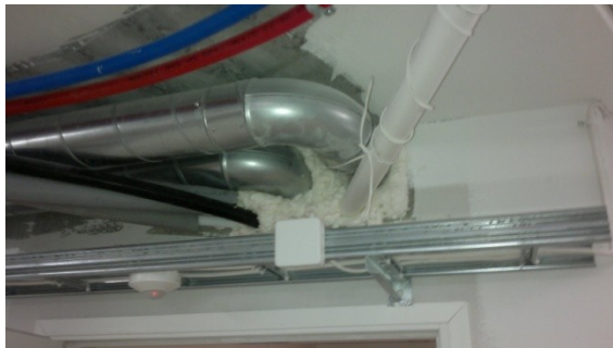
Kuva 45. Keskeneräinen ja väliaikainen tiivistys.
