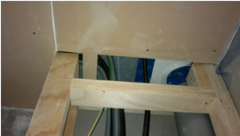
Kuva 25. Esimerkillisesti tehty putkikanaviston tiivistys
