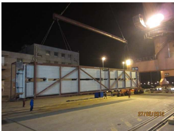
KUVAT 37 ja 38. Oikeanmittainen nostopuomi.
