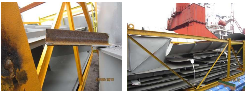
KUVAT 27 ja 28. Irronneet kiinnitykset.
