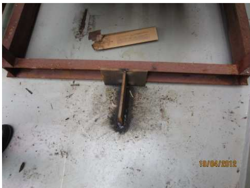
KUVAT 45 ja 46. Hitsatut luistonestot.
