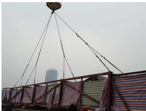
KUVAT 9 ja 10. Virheellisiä nostotapoja.
