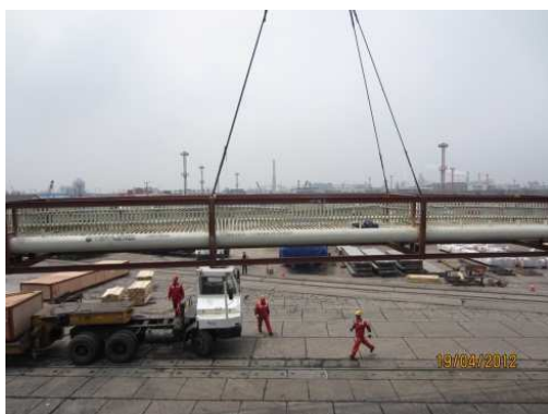
KUVA 39. Virheellinen nosto.
