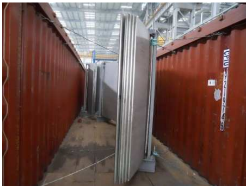
KUVA 13. Kappaleen kiinnitys teräslangalla
