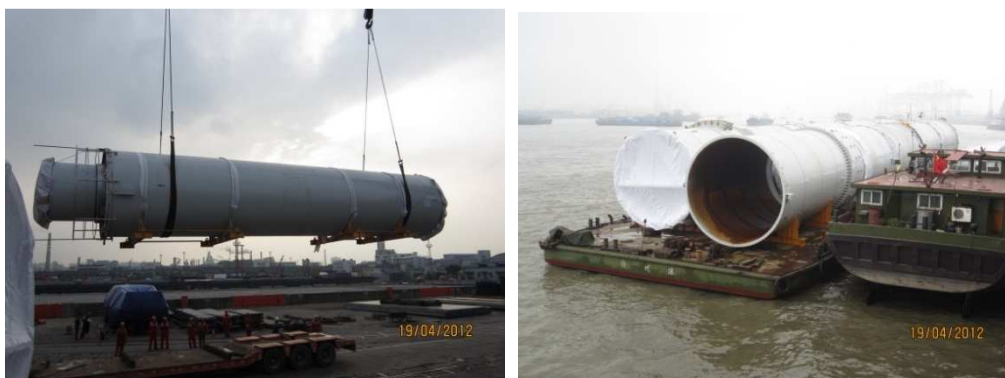
KUVAT 47 ja 48. Piipun lohkojen lastaus kannelle.
