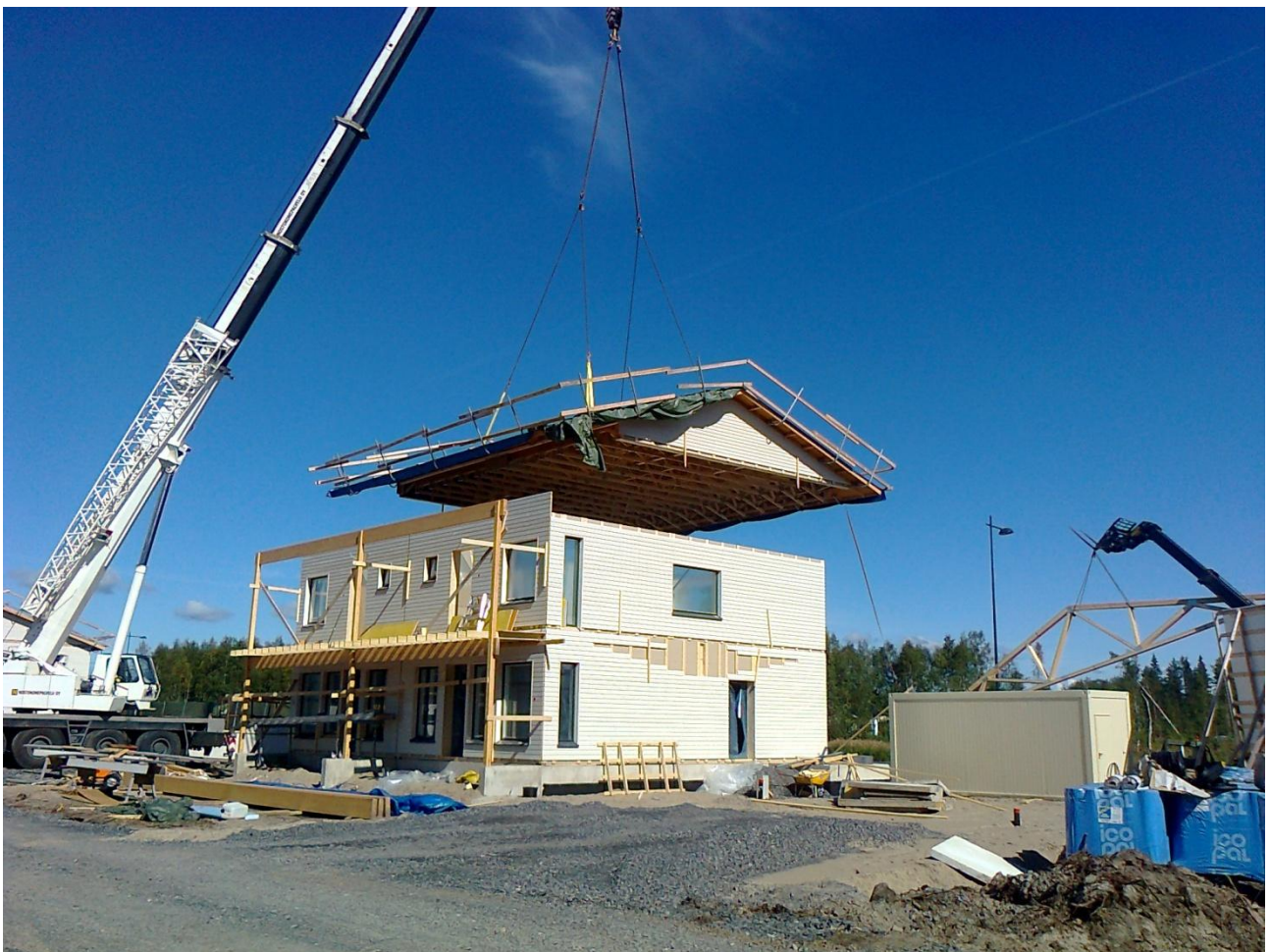
KUVA 8. Paritalon maassa rakennetun katon nostaminen kokonaisuutena paikalleen Ritaharjussa
