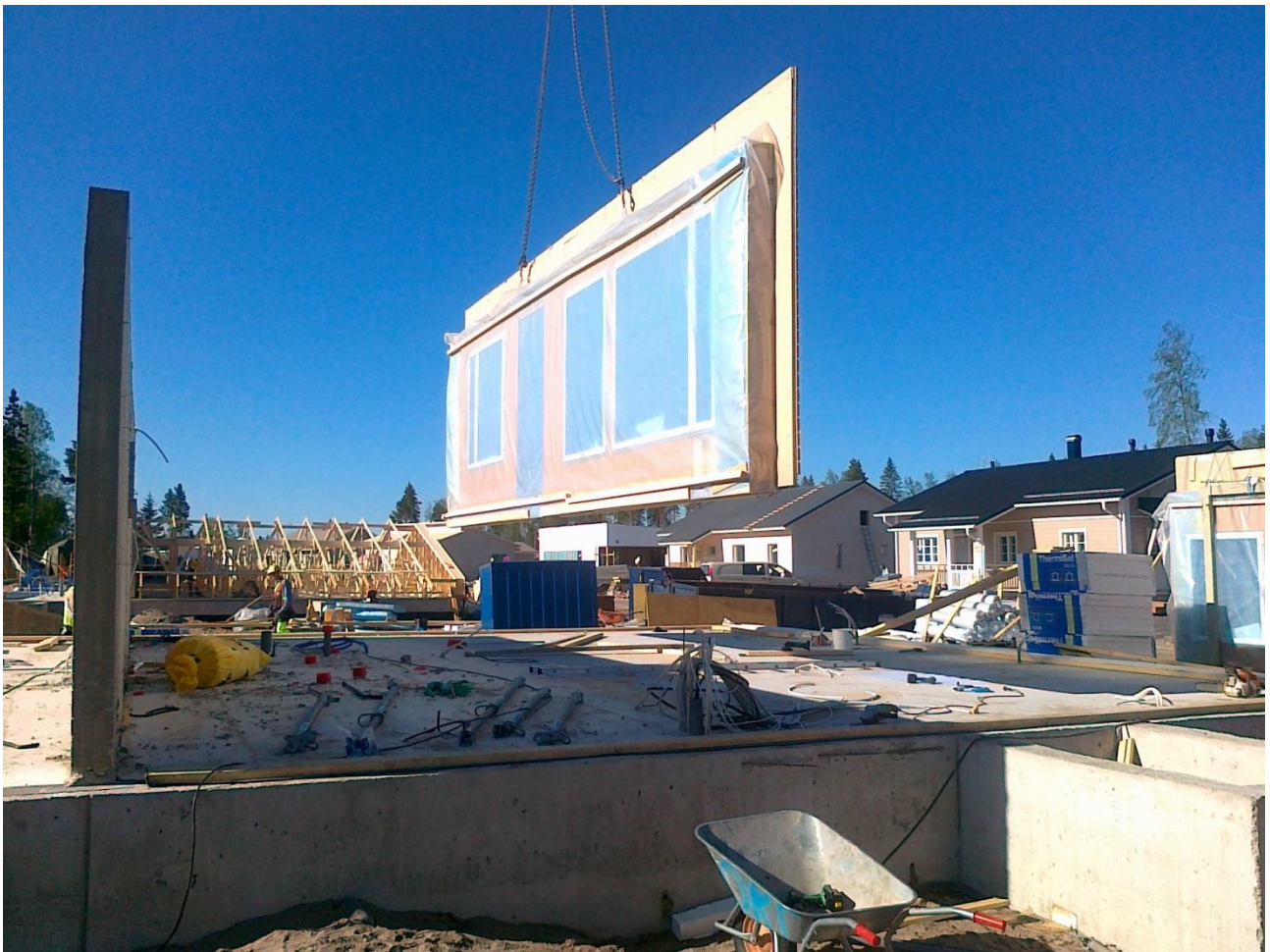
KUVA 4. Rivitalon seinäelementtiä ollaan nostamassa paikoilleen autonosturilla
