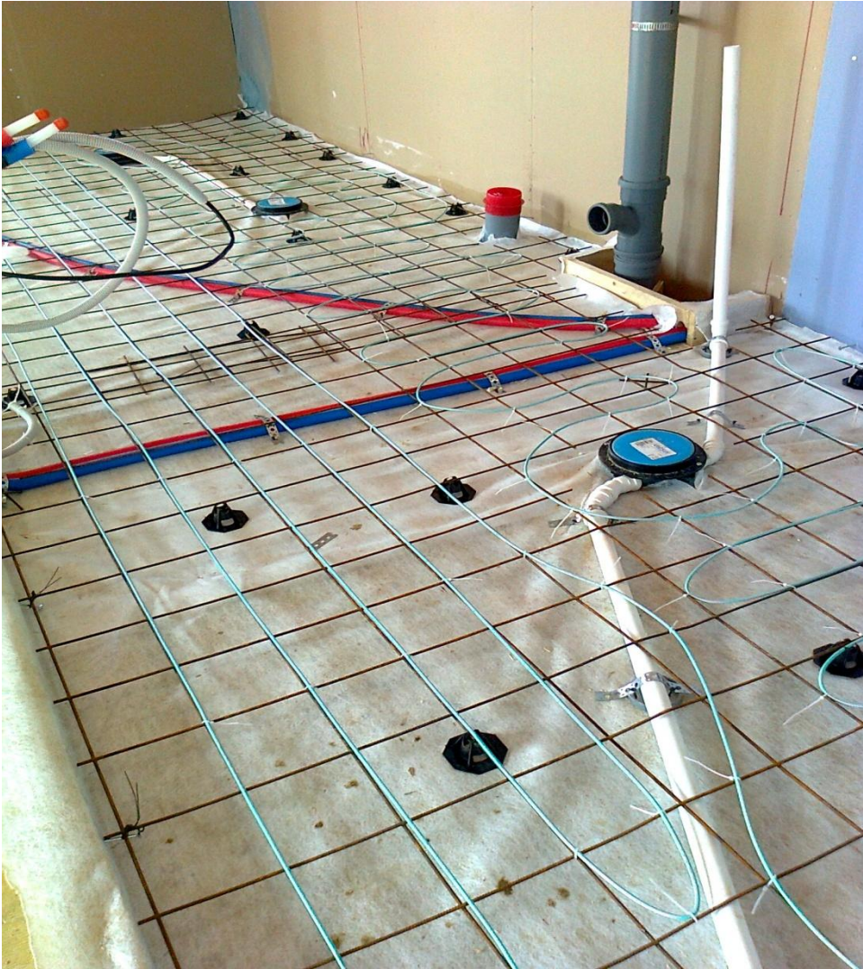
KUVA 6. Välipohjaelementtiin on jätetty tehtaalla syvennys pesuhuoneen ja saunan kohdalle, johon työmaalla valetaan betonilattia
