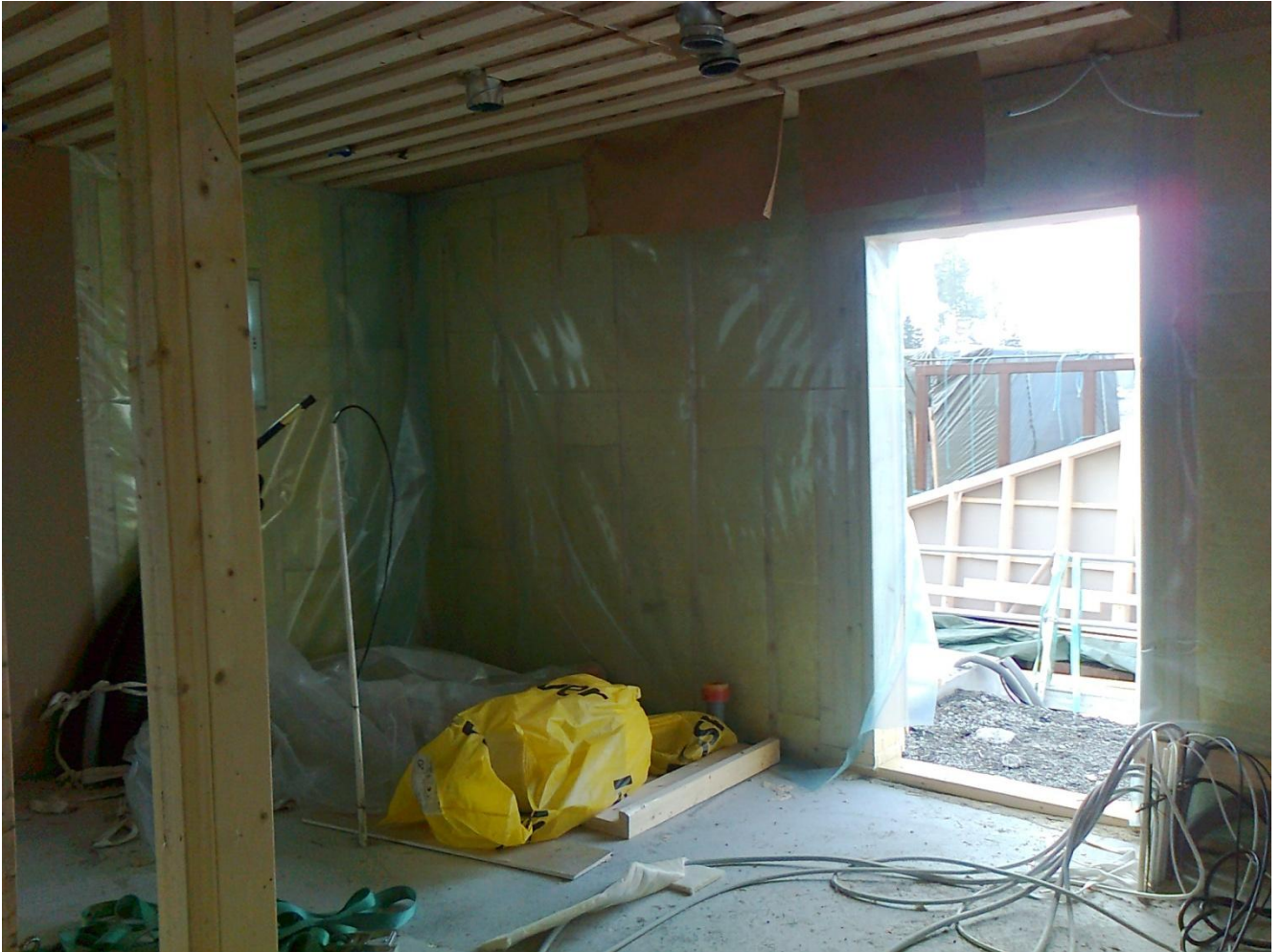
KUVA 7. Kuvassa näkyy kaksikerroksisen paritalon seinä- ja välipohjaelementit paikalleen asennuksen ja asennusaikaisten tukien poiston jälkeen
