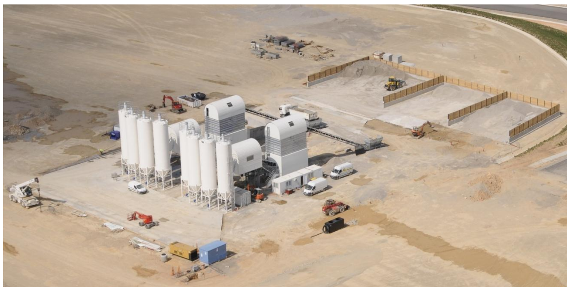
Kuva 3. ITER – International Thermonuclear Experimental Reactor, fuusioreaktorin rakennusalueella oleva betoniasema [3]
