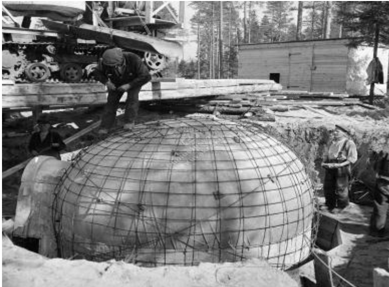
Kuva 17: Muotin raudoitustyö meneillään, (SA- kuva)
