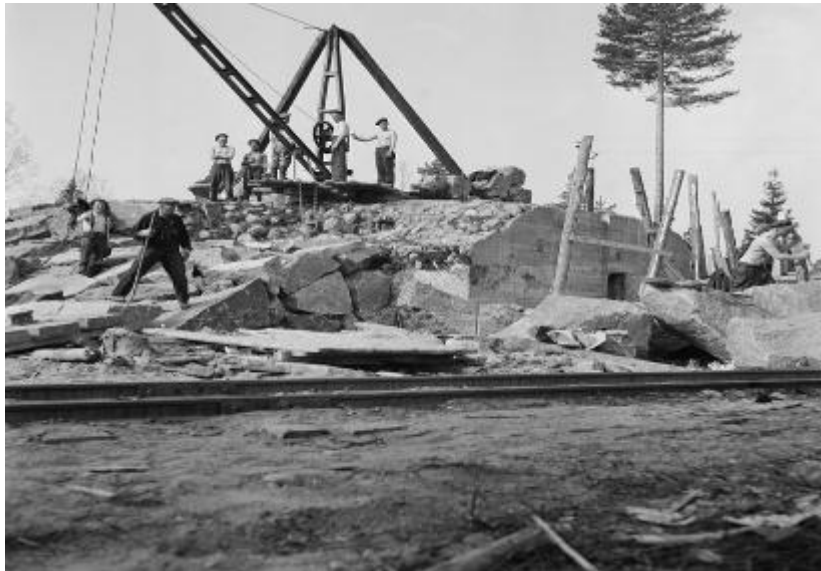
Kuva 10: Kivisuojauksen asennusta korsun ympärille, (SA-kuva)
