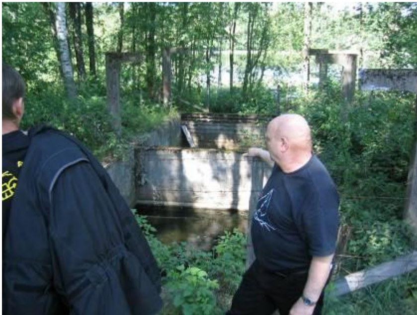
Kuva 24: Kivijärven patorakenteet, (Internet-kuvahaku)
