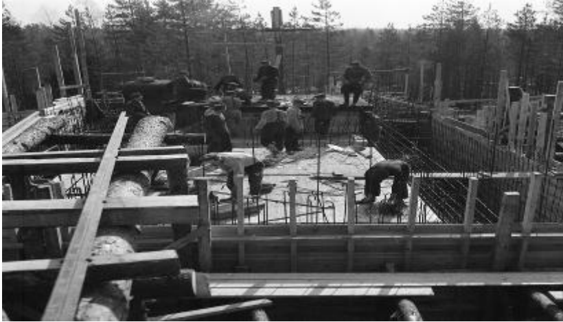
Kuva 8: Betonimuotin laudoitustyöt käynnissä, (SA- kuva)
